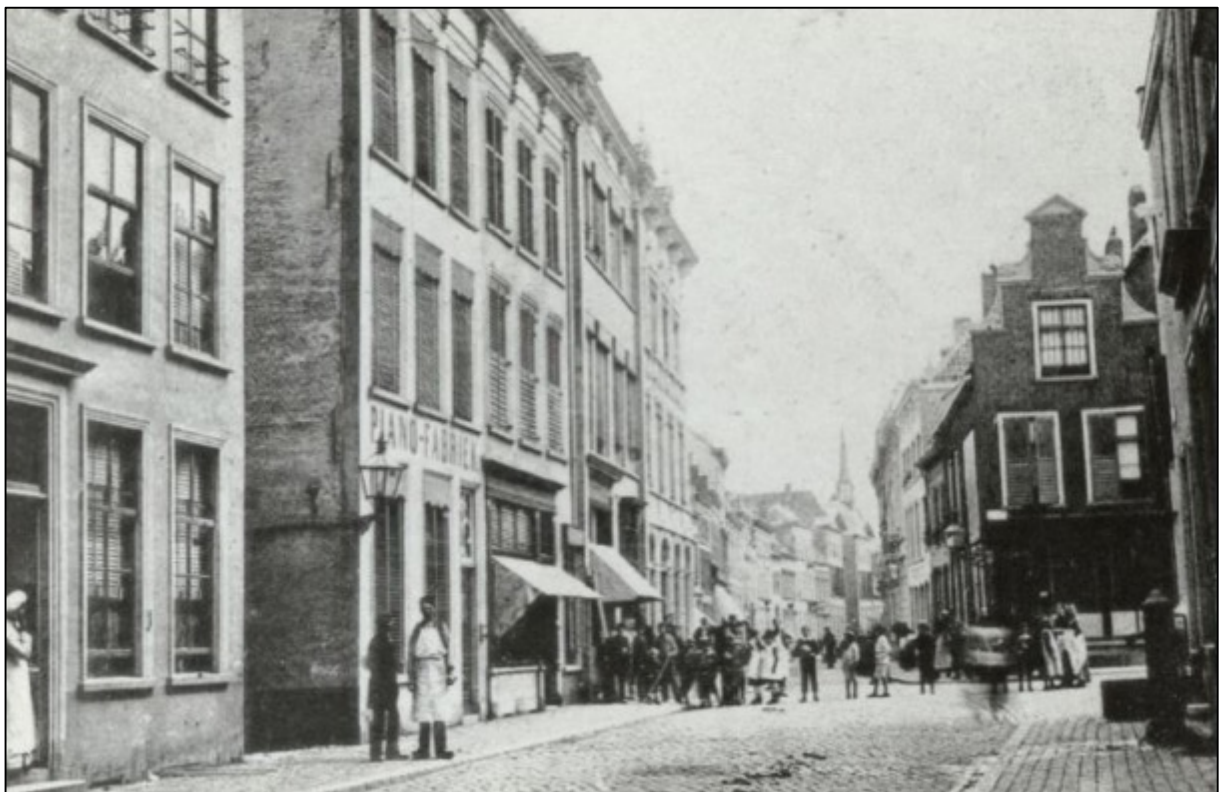
Afb. 47: Straatbeeld waarop de 19de-eeuwse toestand van de voorgevel te zien is. De pui van nr. 8 lijkt op wat later als 'bestaand' op tekening werd gezet, maar de grote ruit heeft nog een bovenlicht met indeling. Reigerstraat 10 heeft een onderpui met drie traveeën zoals op de verdiepingen. [SAB]
