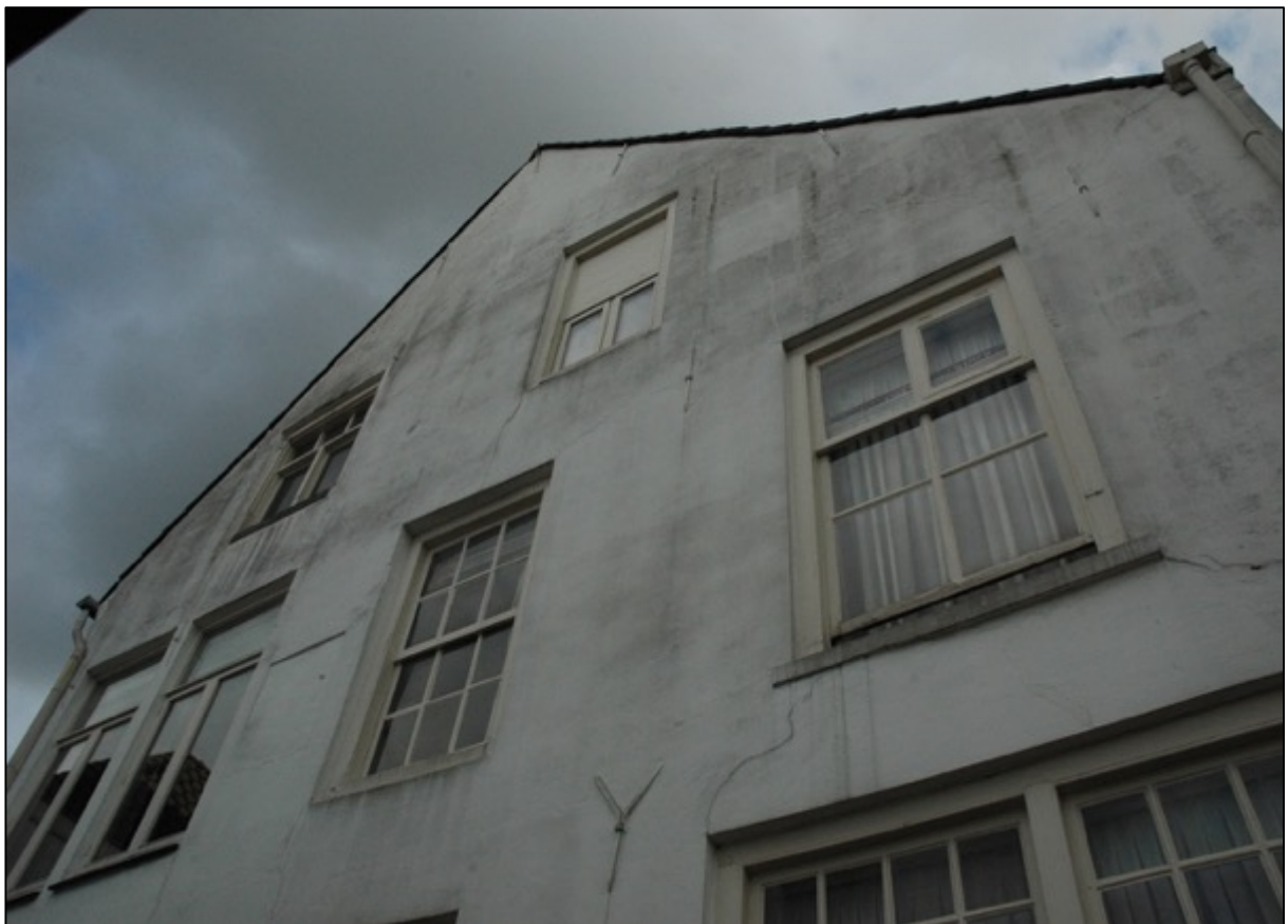
Afb. 14: De top van de achtergevel van nummers 8 (links) en 10. De gevel is een staalkaart van venstertypes en fases.
