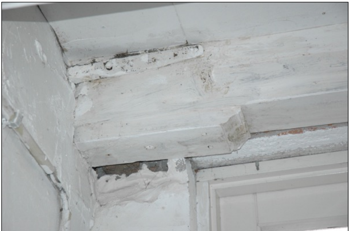
Afb. 18: In het voormalige pakhuis, Riegerstraat 10 B, zijn enkele balken boven het systeemplafond waargenomen. Het pand blijkt een zoldervloerconstructie te bevatten met een enkelvoudige balklaag in grenenhout. In de hoek rechtsvoor is op de verdieping dit sleutelstuk zichtbaar. De bewerking / versiering maakt datering rond het begin van de 17de eeuw mogelijk.
