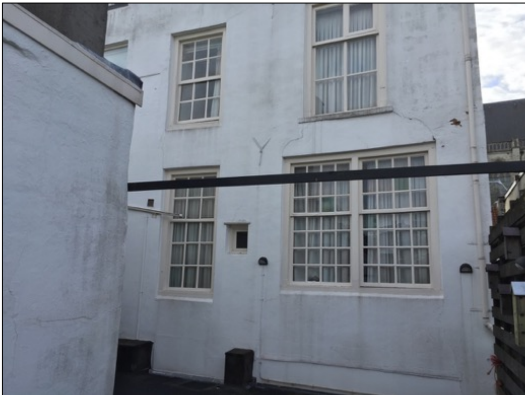
Afb. 53: Detail van de achtergevel van Reiger- straat 10. [Foto Ivo de Bruin / Studio PUUR NL]
