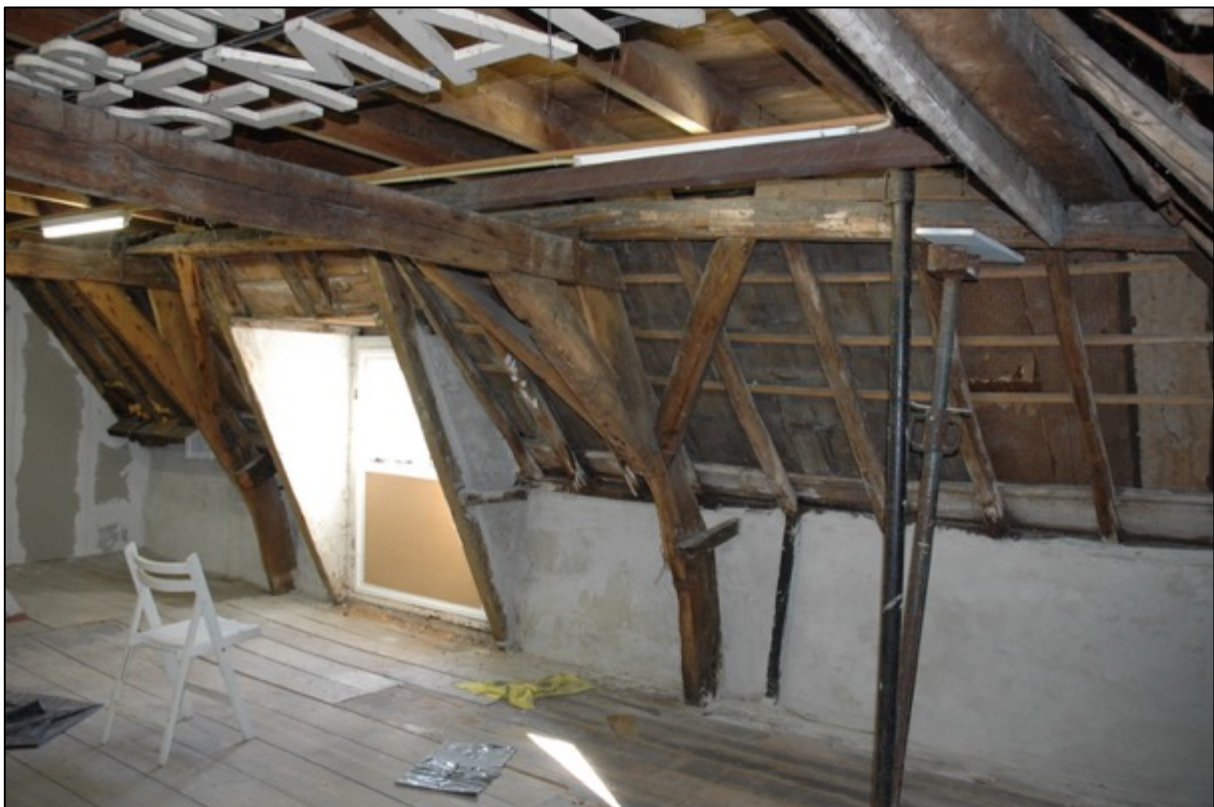
Afb. 22: De zolder van Reigerstraat 10 B, gezien naar linksvoor, met de dakkapel die als laadopening gefungeerd heeft.
