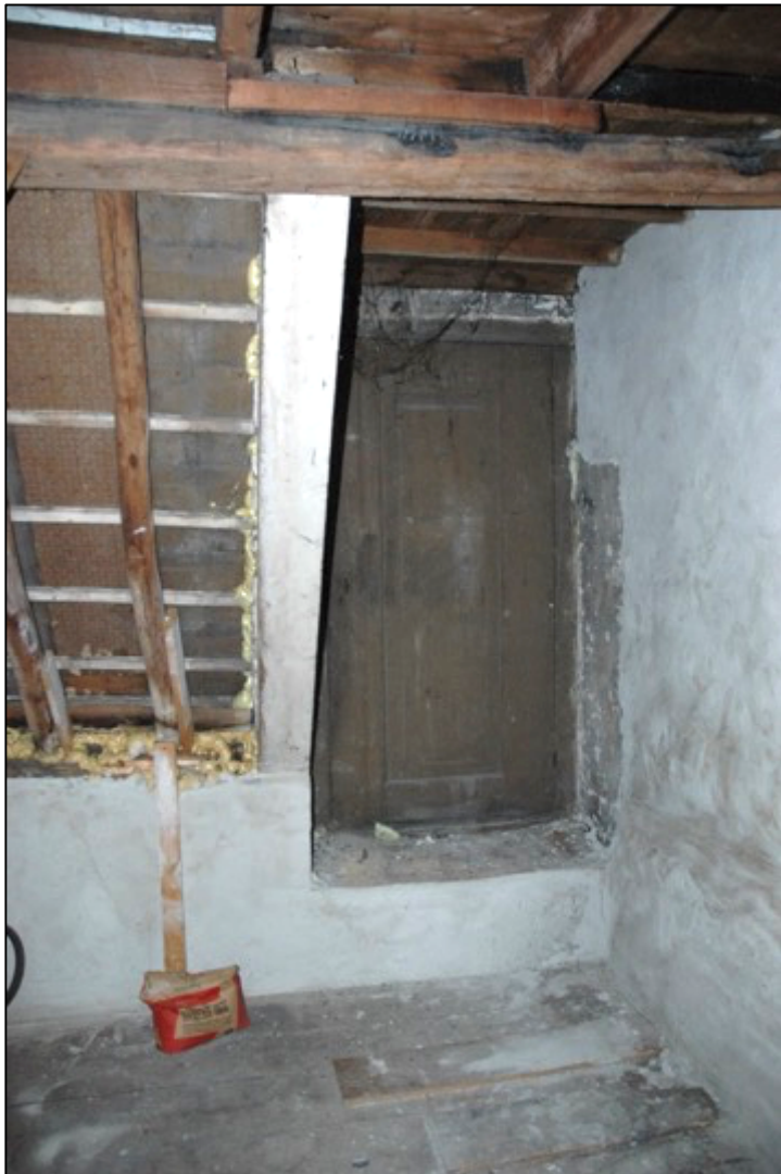
Afb. 35: Bouwdeel 10 B bevat op drie bouwlagen vooraan in de rechtermuur een nis of doorgang die getuigt van vroegere verbondenheid met het rechts aangrenzende gebouw, behorend tot Reigerstraat 6.
