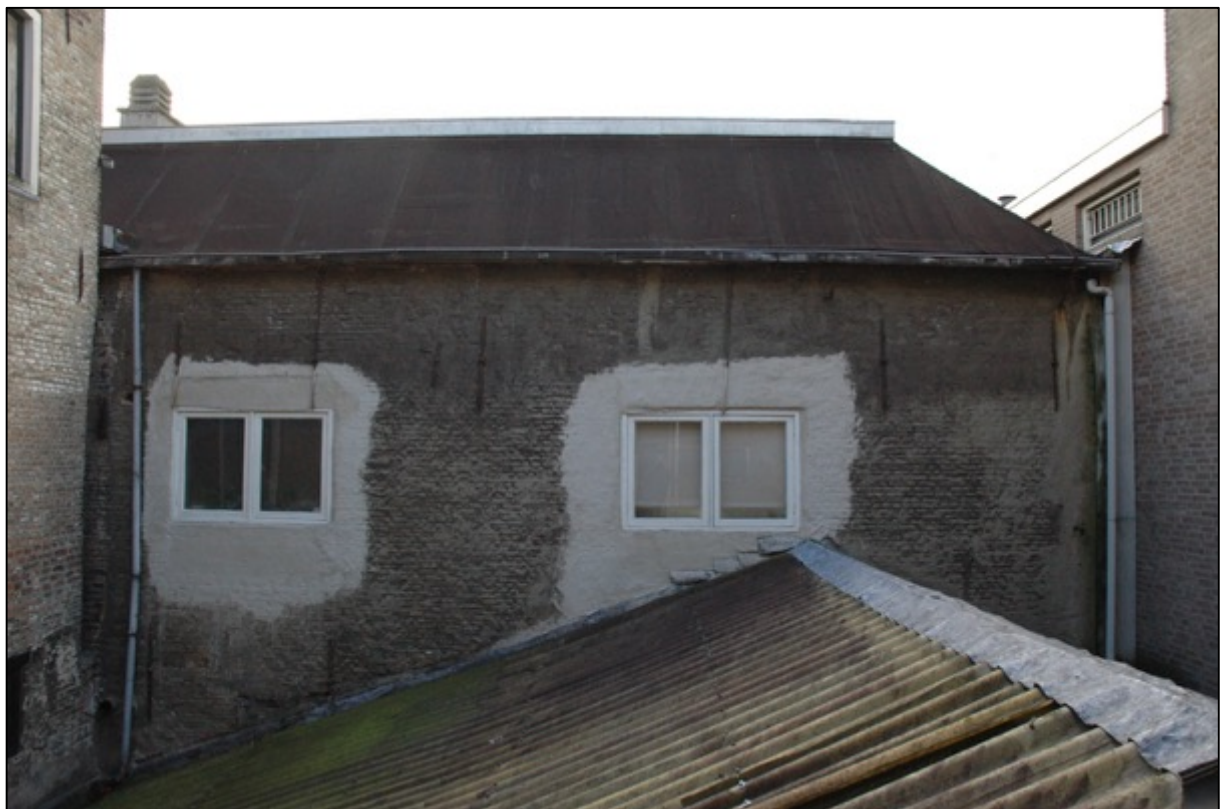
Afb. 59: Dezelfde gevel tegenwoordig.
