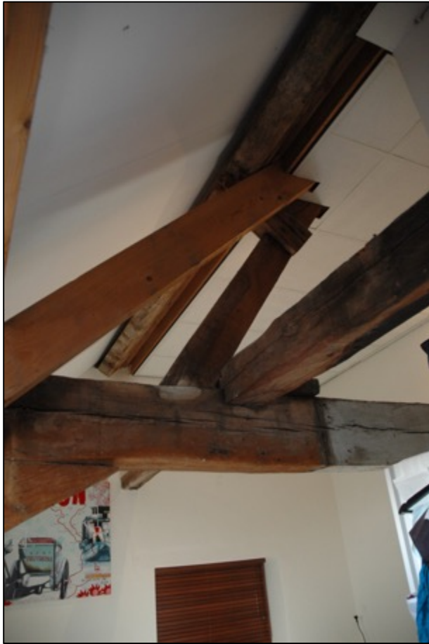
Afb. 36: De zolder van Reigerstraat 10. In de slaapkamer achteraan is een van de oudere eiken spanten behouden. De kleurafwerking, die scherp afbreekt, is het restant van een vroegere indeling van de zolder.
