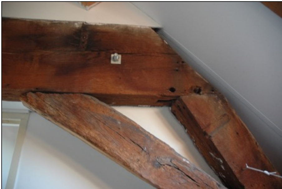
Afb. 19: Het voorlaatste halfspant op de zolder van Reigerstraat 10 is een van de vele voorbeelden in deze kapconstructie van de complexiteit die gemoeid is met de analyse, door de vele renovaties.
