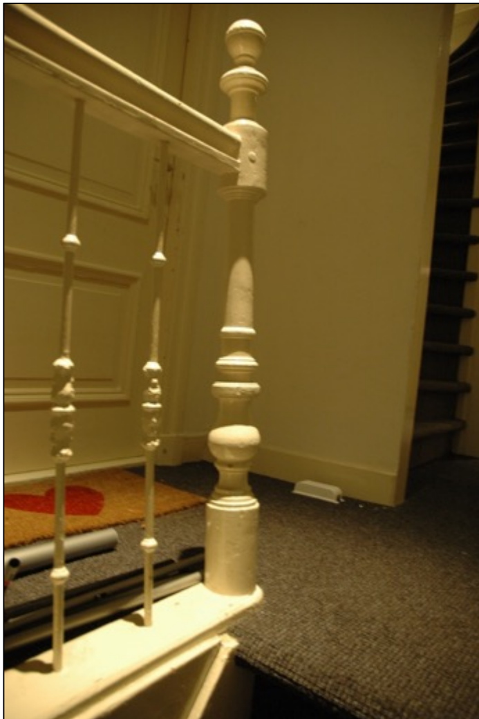
Afb. 30: De gesneden trappaal en het spijlenhekje op de eerste verdieping van nr. 10. Zij ogen gelijktijdig met de deur die nu de entree van het appartement vormt. Dit overloopje lijkt daarmee ongewijzigd sinds de latere 19de eeuw.
