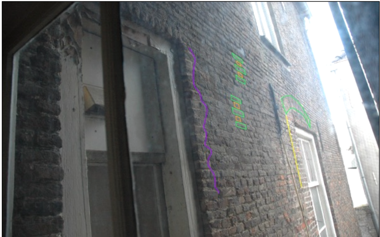
Afb. 52: De zijgevel aan de rechterkant van Reigerstraat 8 met geaccentueerde bouwsporen.
