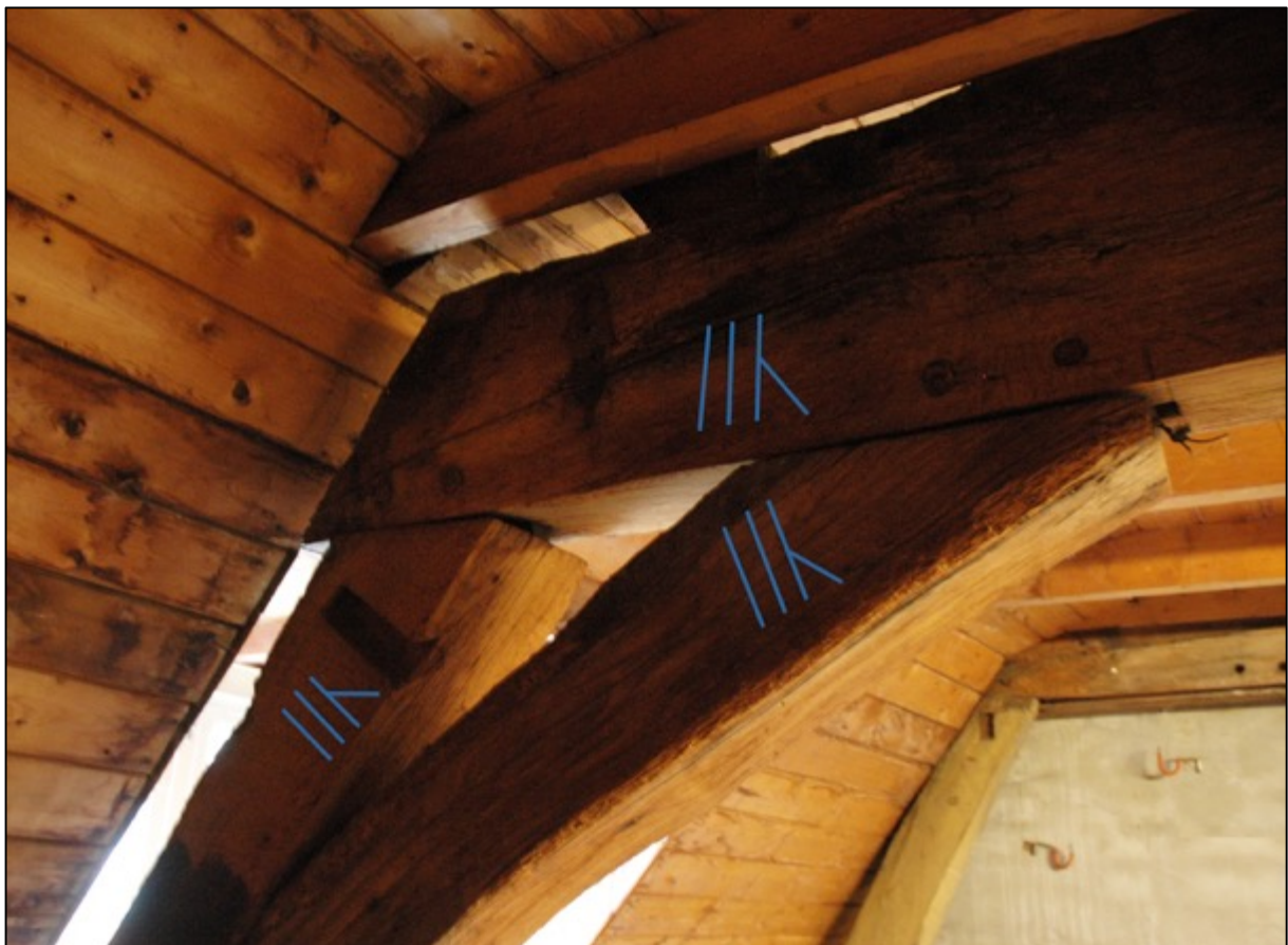
Afb. 45: In blauw aangezet de telmerken van het meest rechtse halfspant onder het voorste dakschild: 3 met richting-aanduiding.
