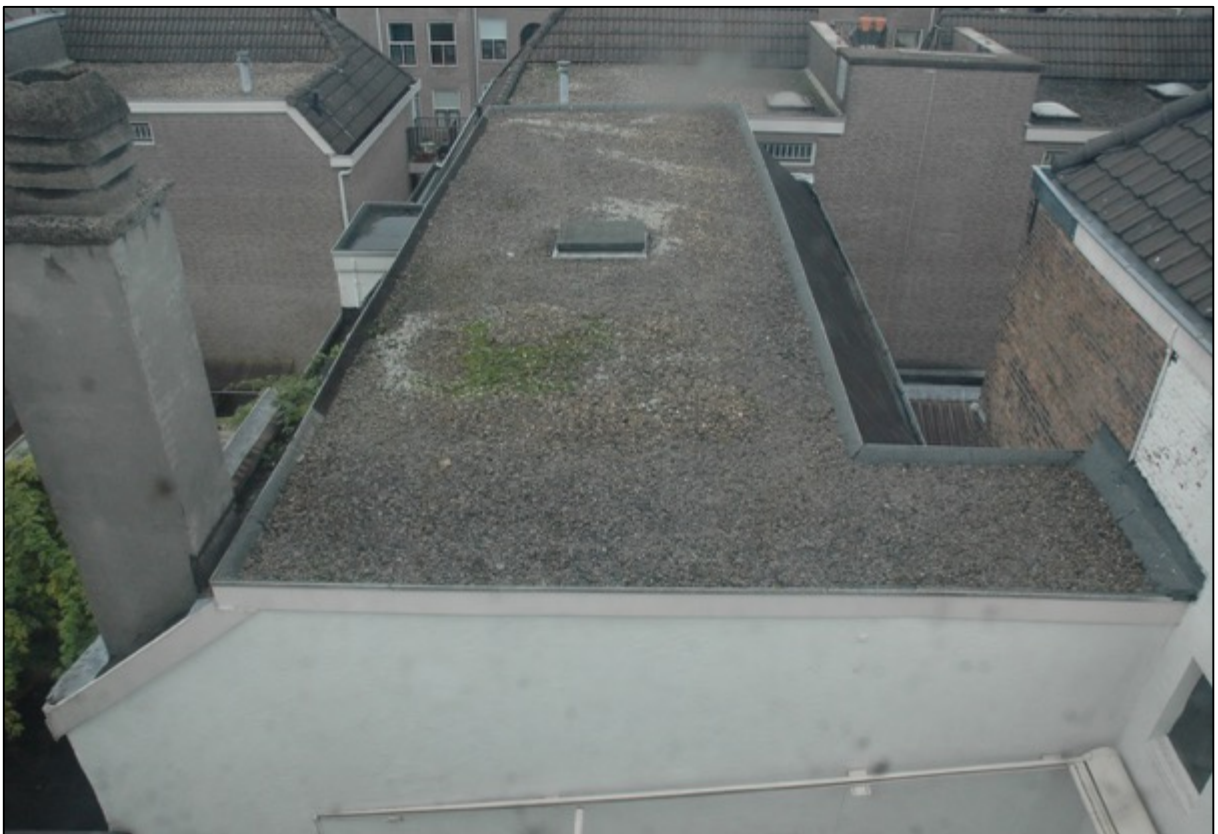
Afb. 9: Zicht op het dak van Reigerstraat 10 B, van voor naar achter, anno nu.
