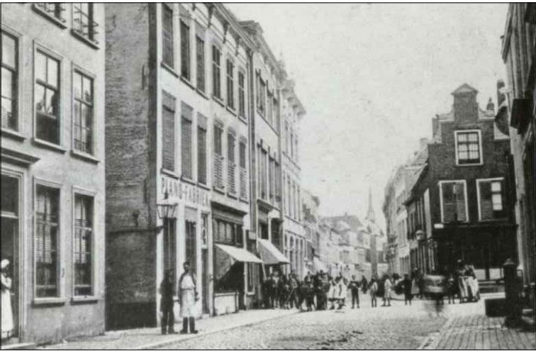
Straatbeeld waarop de 19de-eeuwse toestand van de voorgevel te zien is. De pui van nr. 8 lijkt op wat later als 'bestaand' op tekening werd gezet, maar de grote ruit heeft nog een bovenlicht met indeling. Reigerstraat 10 heeft een onderpui met drie traveeën zoals op de verdiepingen. [SAB]
