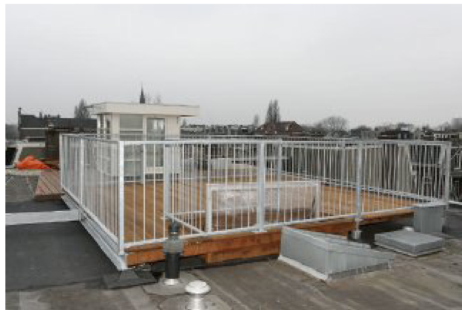
Dakterras op hoofdbebouwing
