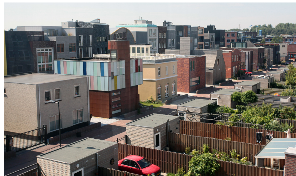
Dakopbouwen op Steigereiland
