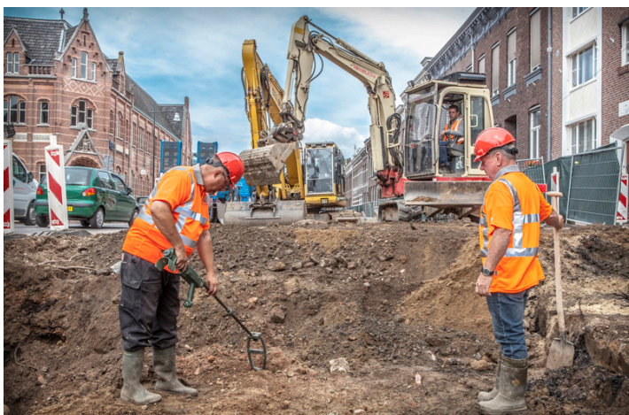
Afbeelding 8. Uitvoeren actieve analoge oppervlakedetectie m.b.v. Vallon VMM/ VMH3CS non Ferrous Locator en staafdiagram waarop het maximale detectiebereik (m1 – mv) per kaliber is aangegeven.
