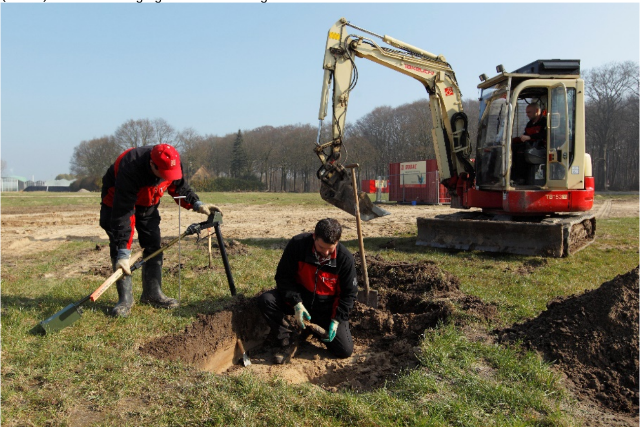
Afbeelding 4. Benaderen objecten m.b.v. beveiligde graafmachine.
