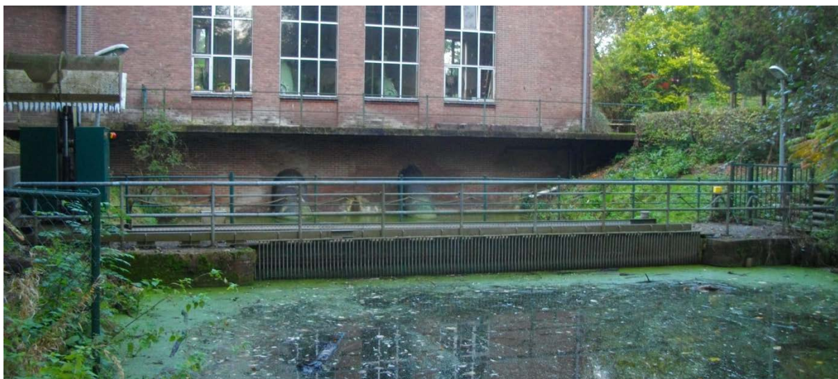
Figuur 4.6 Het krooshek van gemaal Schiphoudijk met aan de linker kant de automatische krooshekreiniger
