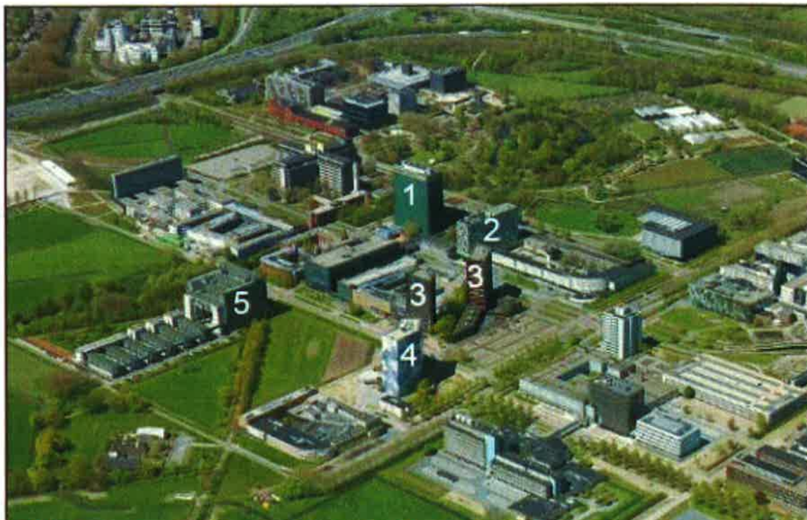
Afbeelding 3: de 6 hoge gebouwen op het terrein. 1 = W.C. van Unnikgebouw, 2 = Casa confetti, 3 = De Bisschoppen, 4 = Johanna, 5 = gebouw Cambridgelaan
