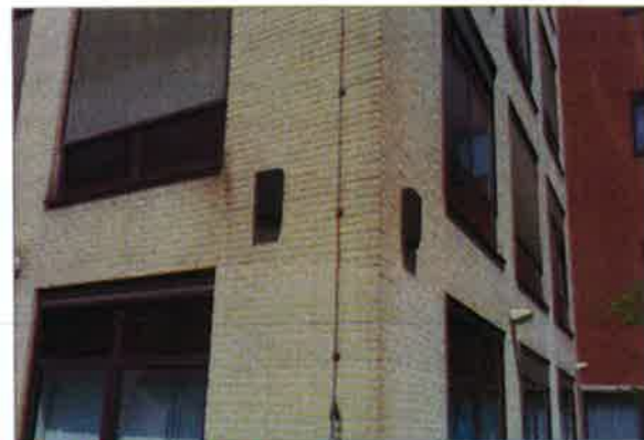
Figuur 11. Kasten aan het gebouw.
