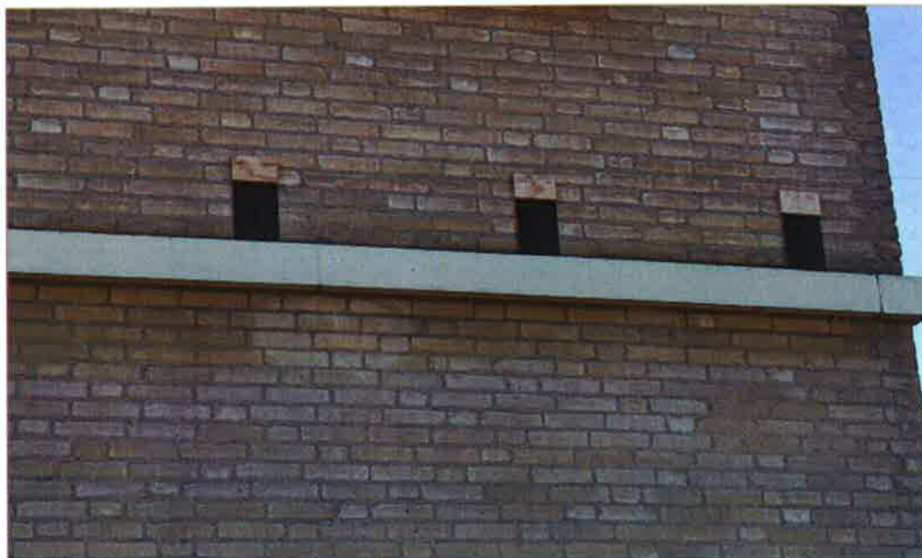
Figuur 13: Voorbeeld: exclusion flaps voor open stootvoegen.
