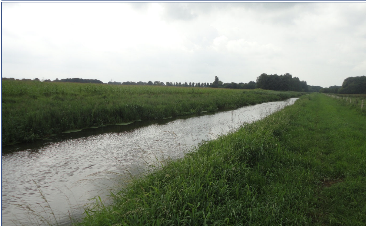
Figuur 17: Aanzichten van de Loobeek-Afleidingskanaal in oostelijke richting.
