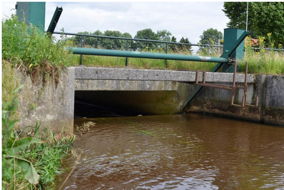
Figuur 5.5 Bestaande situering stuw ter hoogte van de A73.
