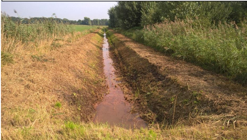
Foto 18: Tracé Venraysche Broek, kijkend stroomafwaarts, watergang Turfgaten
