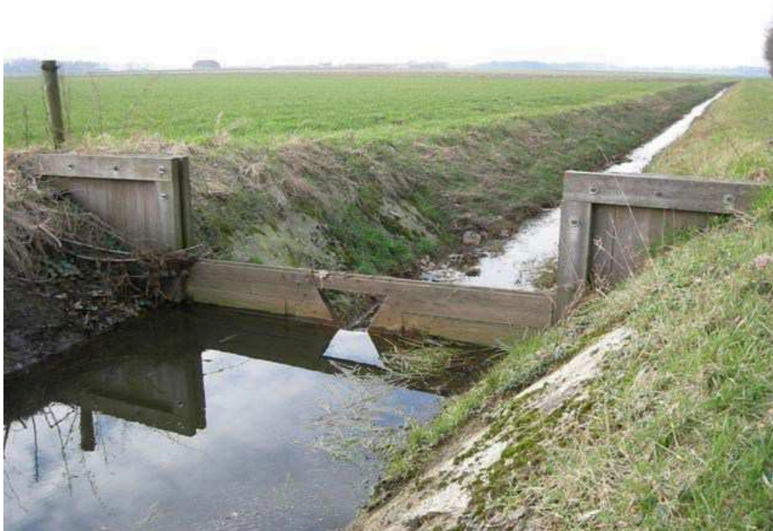
Figuur 6.1: Voorbeeld van een knijpstuw
