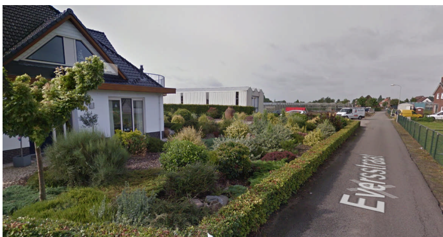
Figuur 2 Te saneren kassen aan de Eversstraat 2b. De bedrijfswoning blijft behouden (bron: GoogleStreetview)
