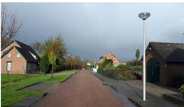
Bebouwing aan de Laurentiusdijk
