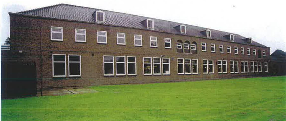
Afb. 52 (boven) Overzicht van de westgevel van het oostelijke carré-vormige gebouw, het economiegebouw. De bakstenen westgevel is voorzien van een arcade met natuurstenen kolommen met daarover een houten draagbalk die de aankapping draagt. Op de hoeken van de gevel sluit een verbindingsgang aan.
