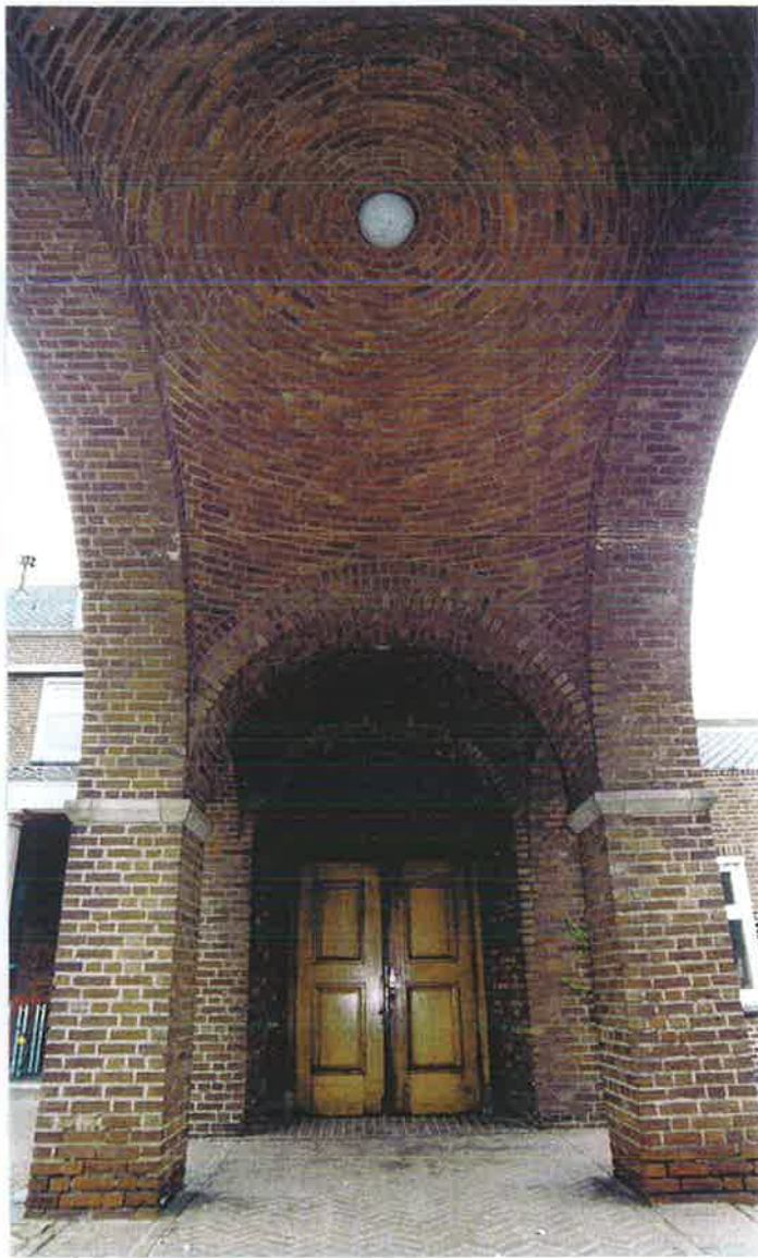
Afb. 48 (links) Overzicht van een toegang in de noordelijke verbindingsgang tussen beide carré-vormige gebouwen. De toegang is voorzien van een oorspronkelijke houten deur. De deur is voorzien van een ijzeren traliewerk met daarachter een getst glaspaneel met klokjes.
