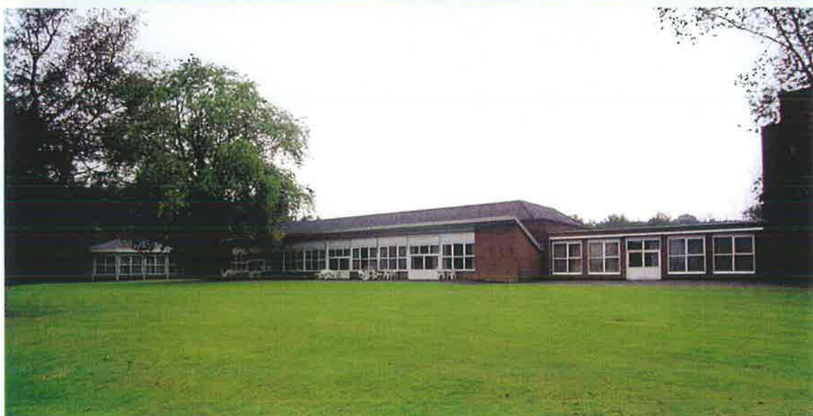
Afb. 36 (boven) Overzicht van de zuidgevel van de oostelijke verplegingsvleugel. De zuidgevel heeft een getrapte opbouw met op de begane grond en tweede verdieping respectievelijk de voormalige openlucht beddenhal en ligstoelenhal. De open opzet van deze hallen is recentelijk bij een renovatie gewijzigd.
