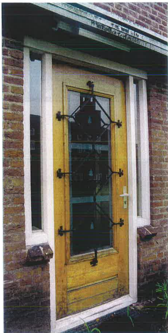
Afb. 48 (links) Overzicht van een toegang in de noordelijke verbindingsgang tussen beide carré-vormige gebouwen. De toegang is voorzien van een oorspronkelijke houten deur. De deur is voorzien van een ijzeren traliewerk met daarachter een getst glaspaneel met klokjes.
