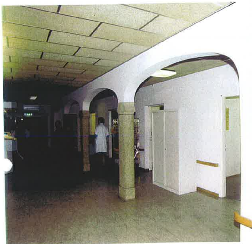
Afb. 42 (links) Overzicht in westelijke richting van de gang op de eerste verdieping van het hoofdgebouw. In de gang is een hal gecreëerd door middel van natuurstenen kolommen die de draagmuren vervangen.
