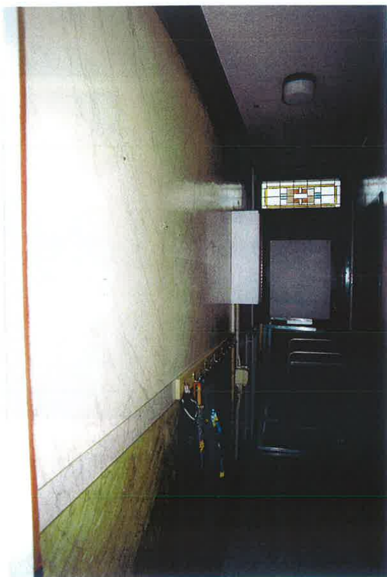
Afb. 73 Overzicht in westelijke richting van de entree-gang in de boerderij. Deze gang heeft zijn oorspronkelijke afwerking, bestaande uit een terrazo-vloer, (geschilderde) imitatie marmeren wanden en een sober stucplafond. Het schilderwerk in de gang is eveneens de oorspronkelijke kleurafwerking.
