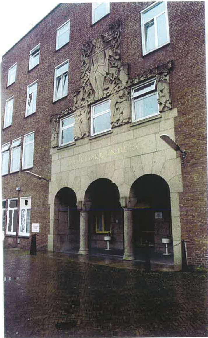
Afb. 30 (links) Overzicht van de hoofdentree in de noordgevel van de hoofdvlugel. De entree met een arcade is uitgevoerd in tufsteen en benadrukt met beeldhouwwerk.
