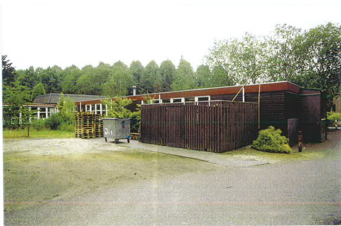
Afb. 78 (boven) Overzicht van de noord-westzijde van het recente noodgebouw aan de westzijde van het westelijke carré-vormige gebouw, het zusterhuis. Dit gebouw bevat onder andere een activiteitscentrum.
