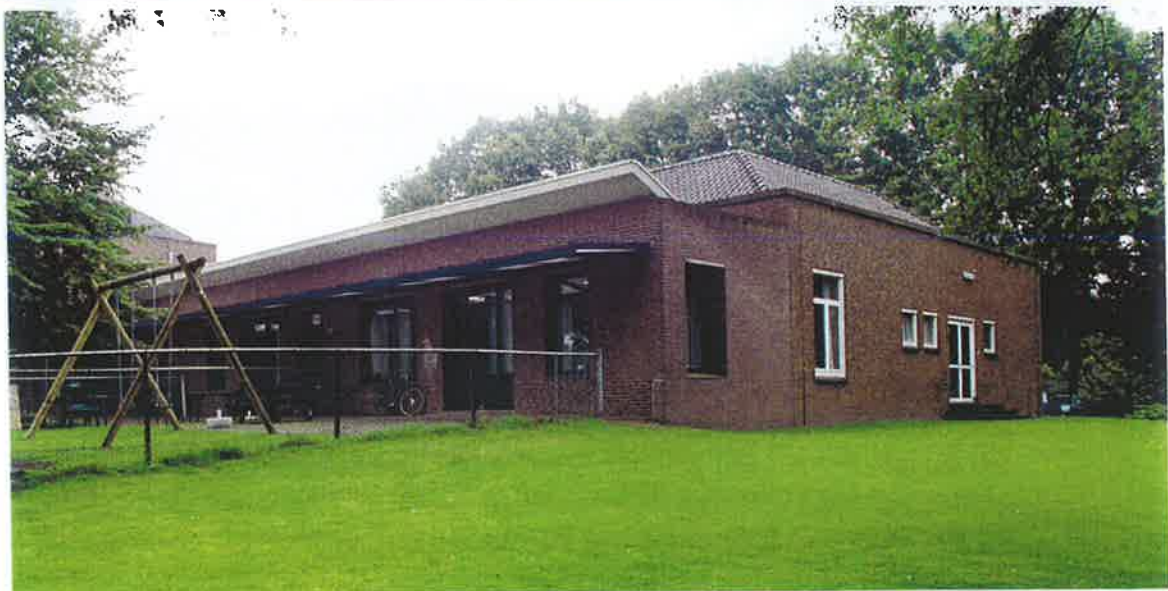
Afb. 34 (boven) Overzicht van de noordgevel van de oostelijke verplegingsvleugel. De noordgevels van de verplegingsvleugels zijn verlevendigd met uitspringende gebogen muurvlakken met daarin glas-in-lood.
