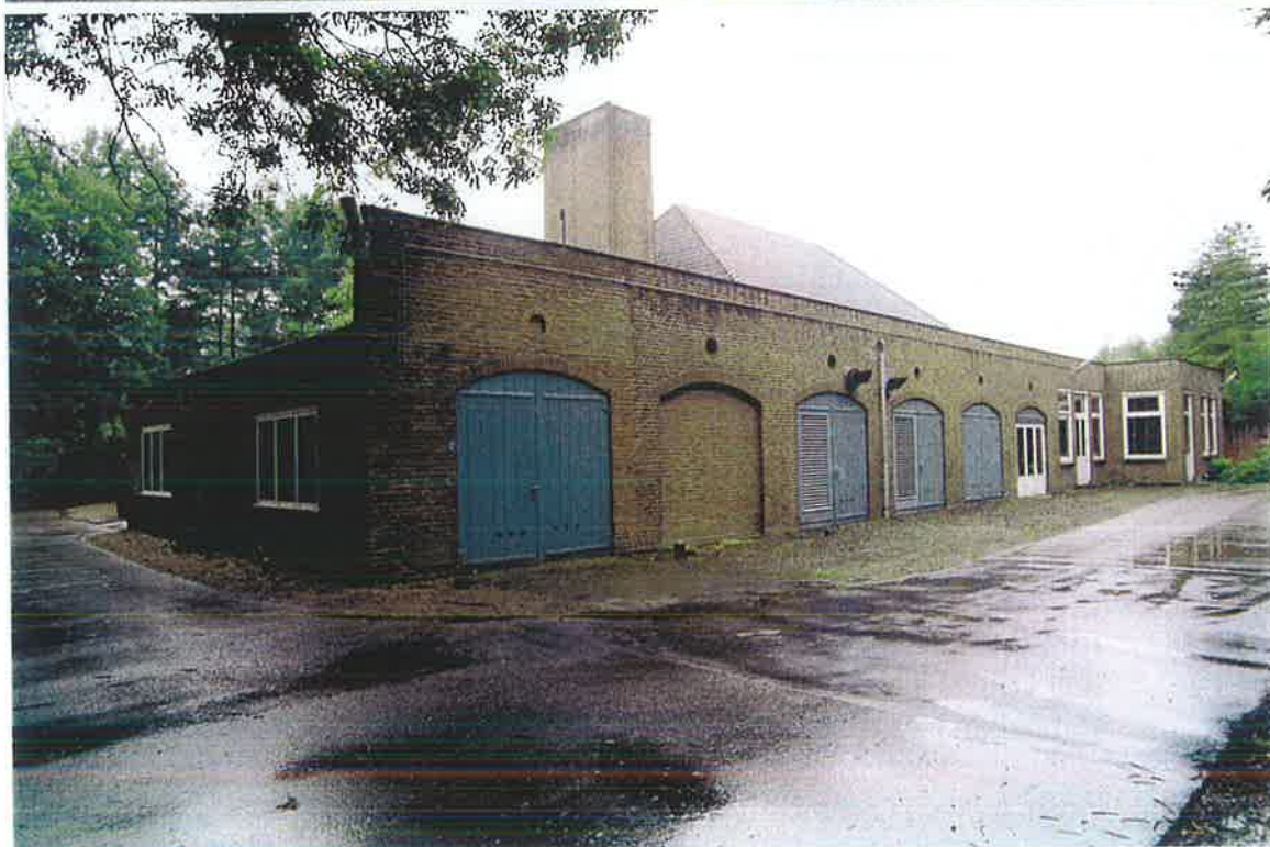
Afb. 67 (boven) Overzicht van de westzijde van het ketelhuis. De gevels van het ketelhuis zijn sobere bakstenen gevels, met een utilitaire venster- en deurindeling. De ramen zijn vrijwel alle vervangen door kunststof. Aan deze zijde zijn thans kantoorvertrekken gesitueerd.
