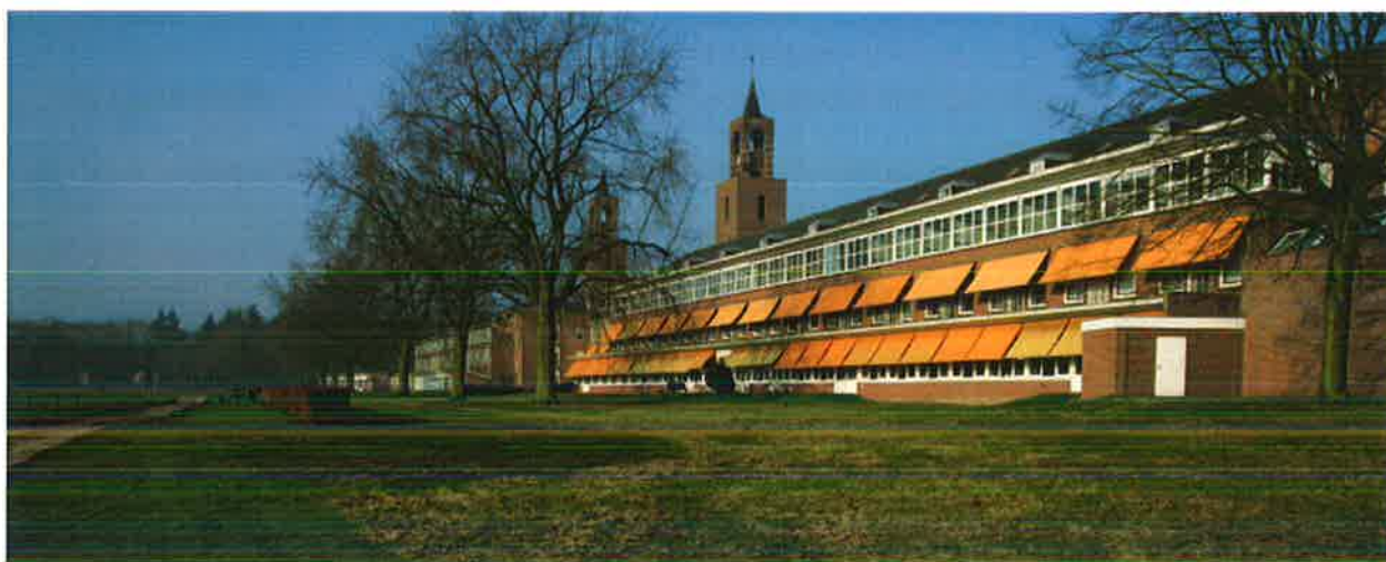
Afbeelding 2.04: De voorname frontgevel van het complex.
