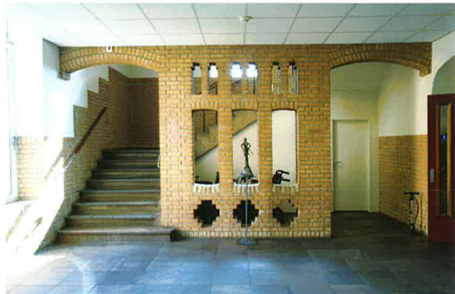
Afbeelding 2.07: Karakteristieke detaillering en materiaaltoepassing ter plaatse van trappenhuisen.
