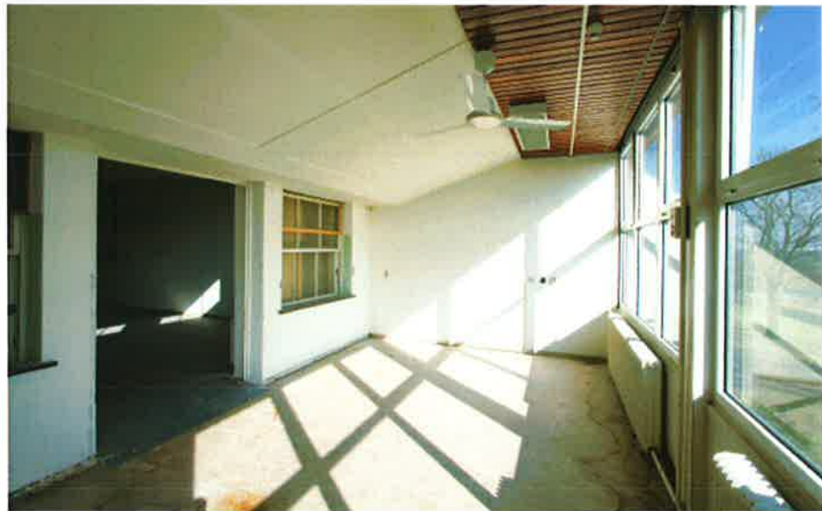
Afbeelding 2.11: Ruimte die oorspronkelijk deel uitmaakte van de langgerekte hal waarin de ligstoelen voor de TBC patiënten stonden opgesteld. Hier nog met enkele oorspronkelijke vensters links.
