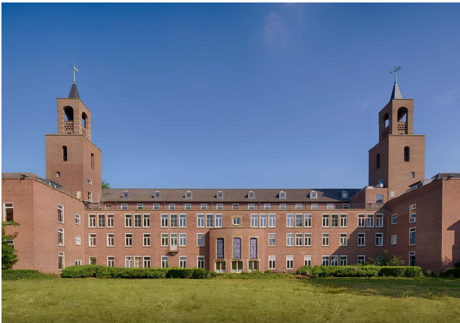
bebouwing met inpandige hemelwaterafvoer
