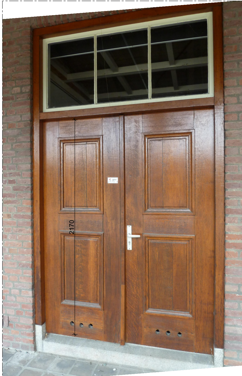
orgineel houten kozijn en stalen bovenlicht
