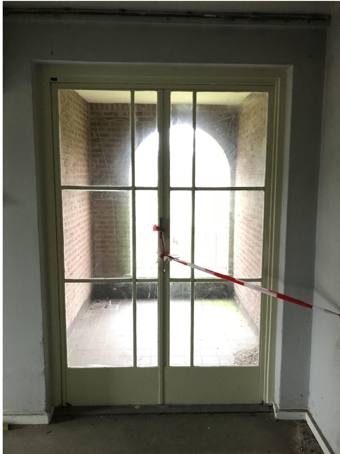
Binnenaanzicht stalen pui loggia woning G04
