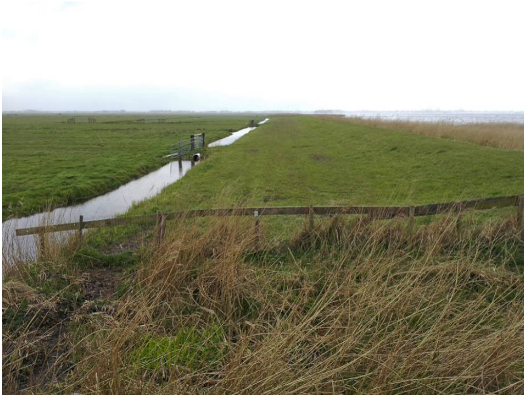
Binnenzijde van de dijk: (beweid) grasland, grenzend aan dijksloot en polderland.
