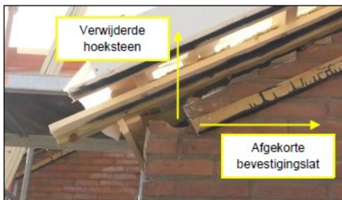
Figuur 2. Voorbeeld maatwerkoplossing. Invliegopening voor gierzwaluwen bij aansluiting dakbeschot en buitenmuur blijft behouden. Details worden nagestuurd.
