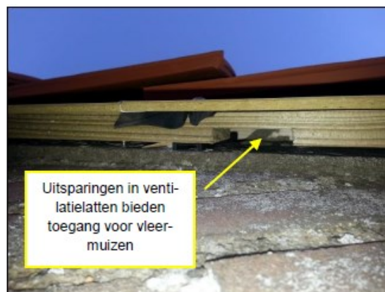
Figuur 4. Vleermuisvriendelijke afwerking dakrand
