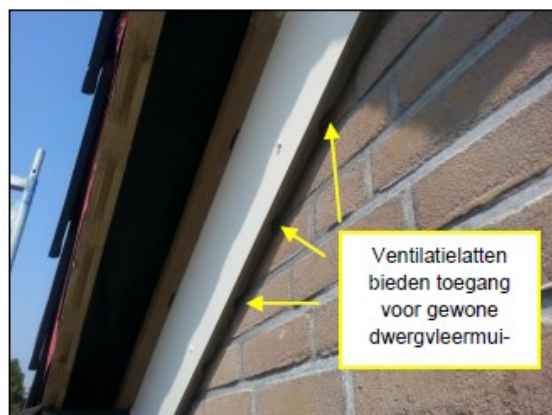
Figuur 3. Vleermuisvriendelijke afwerking dakrand.
