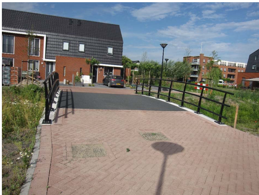
Fig. 1. Hekwerk op brug zorgcentrum
