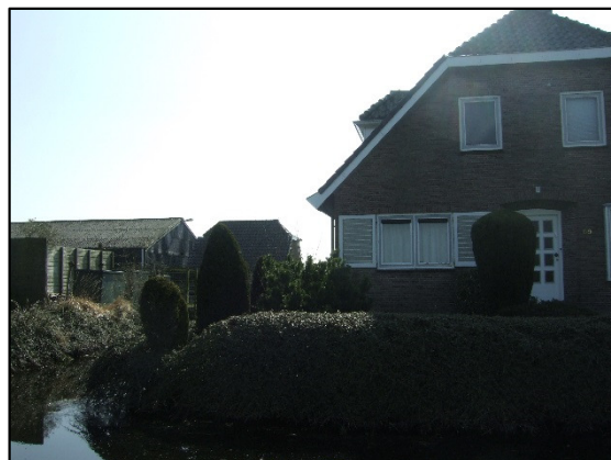
Foto 8: Verblijfplaats huismussen en geschikte locatie voor algemene broedvogels en vliegroute voor vleermuizen.
