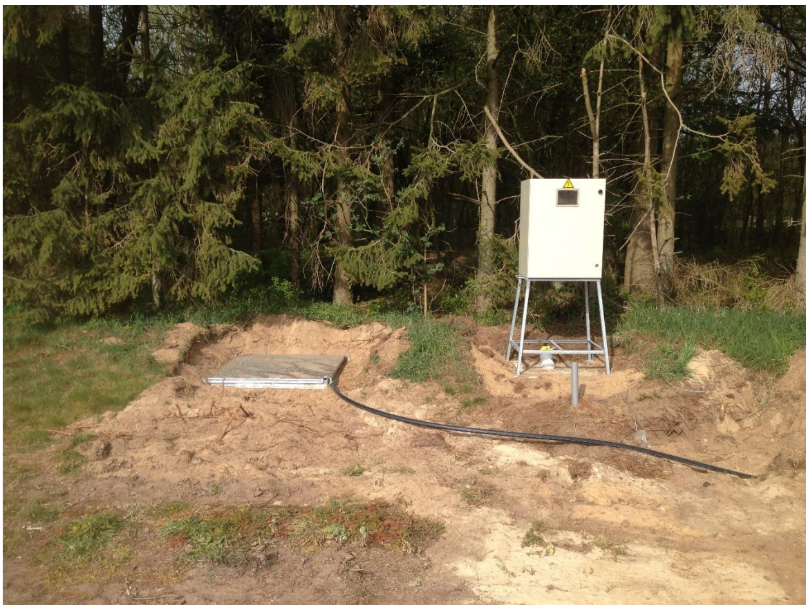
Foto 4: Bouwstroomkast en wateraansluiting
