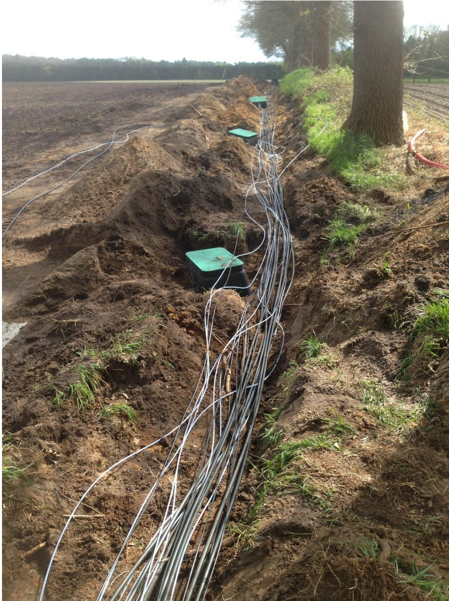
Foto 5: Leidingwerk en putten met de geplaatste LSP's
