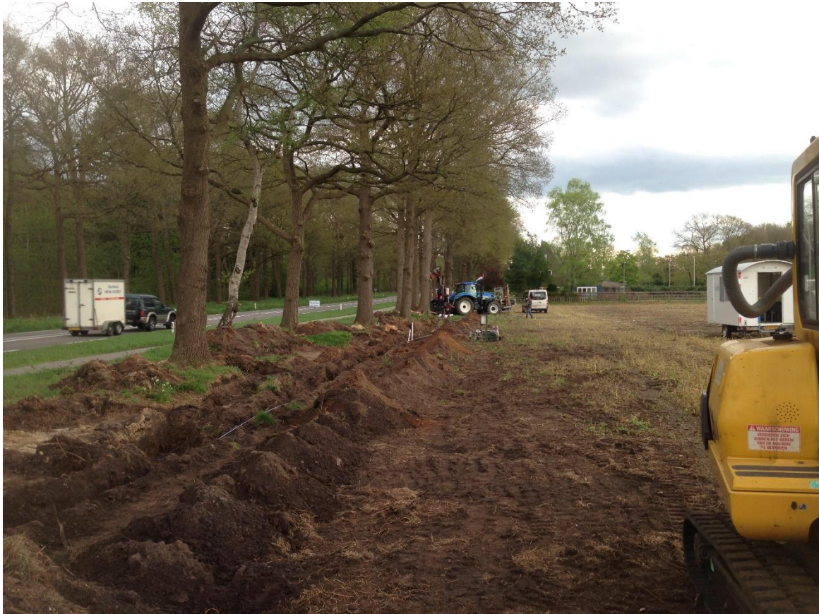
Foto 3: Sleuf voor leidingwerk
