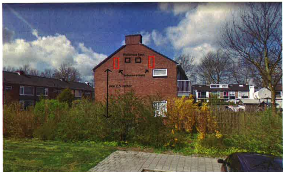
Figuur 3: De plaatsing van inbouwstenen en eventuele andere kasten aan de kopgevel. (voorbeeld van één van de kopgevels)
