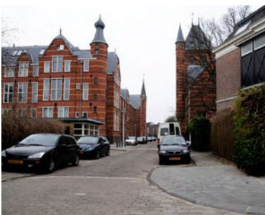
Gebouwen oriënteren op de belangrijkste openbare ruimte(n)
