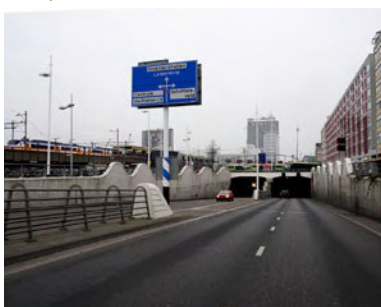
Een deel van de Schipholweg ligt ondergronds
