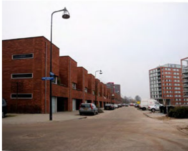
Gevarieerde clusters woningen aan brede straten
