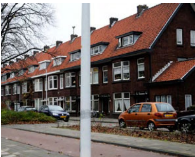
Op-, aan- en uitbouwen vormgeven als ondergeschikt element
