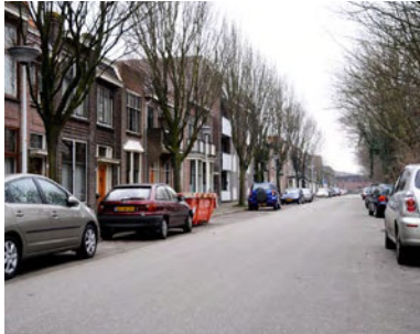
Gevarieerde kleinschalige bebouwing aan overwegend stenige straten
