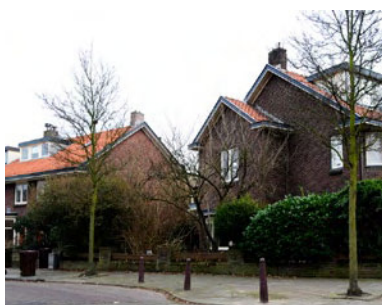
De nokhoogte van aanbouwen is lager dan die van het hoofdgebouw
