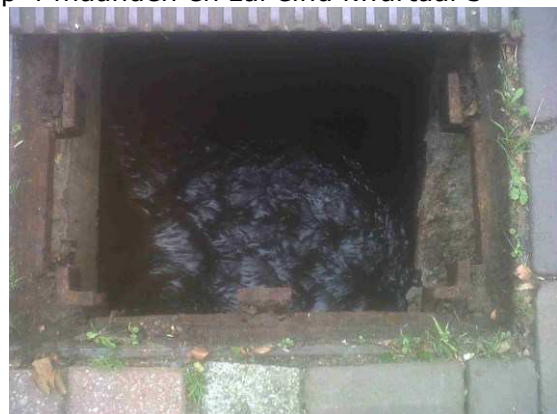
Figuur 9: bestaande put afvoerleiding Sixlaan in trottoir van de Veurseweg
