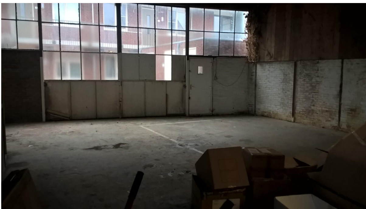
F4 schuur met betonvloer (opslag materiaal)
