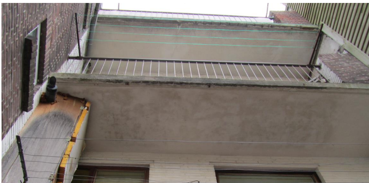
Aanzicht balkons achterzijde
