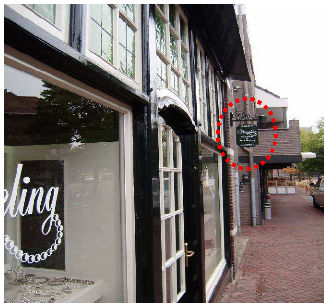
Smeedijzeren uithangbord haaks op de gevel.
