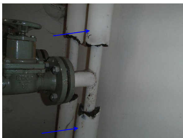
Foto 05: kelder, technisch ruimte, leidingen M04 isolatie - Asbestvrij
