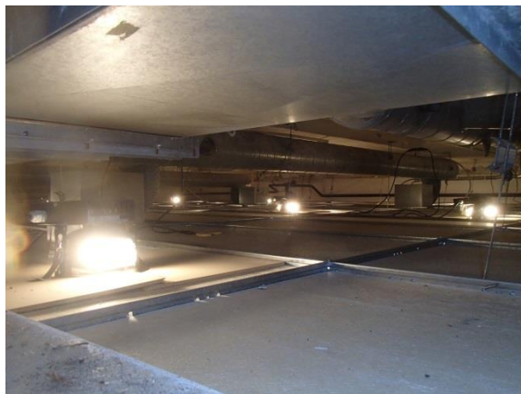
Foto 34: Boven de systeemplafonds Geen asbestverdacht materiaal aangetroffen
