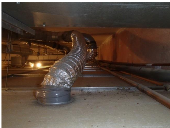
Foto 33: Boven de systeemplafonds Geen asbestverdacht materiaal aangetroffen
