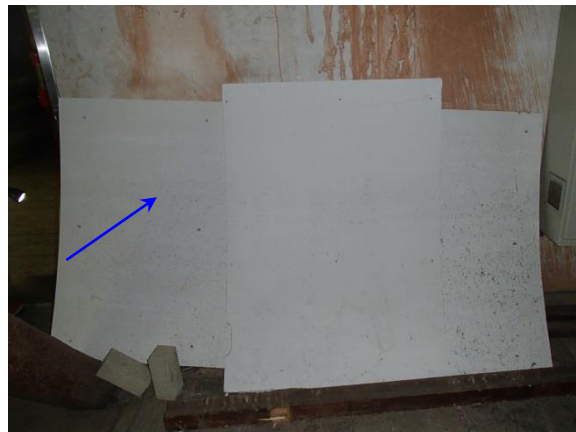
Foto 26: zolder, houten vloer V16 vlakke plaat - Asbestvrij
