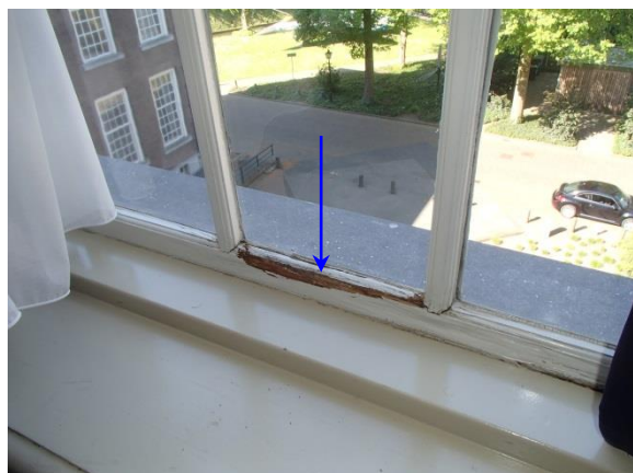
Foto 03: 2 e etage, kamer 230, kozijnen, beglazing M02 kit - Asbestvrij
