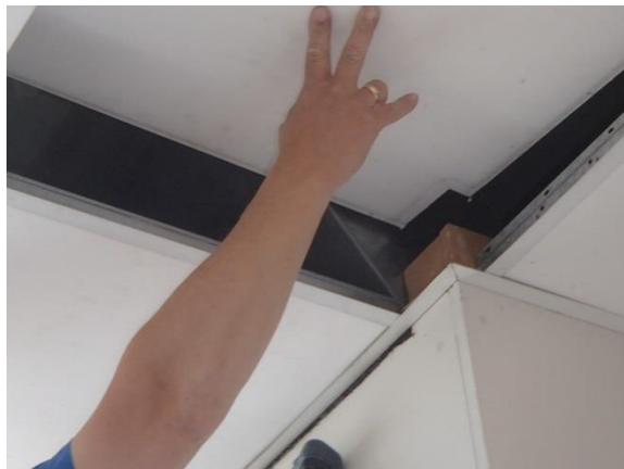
Foto 32: De aangetroffen ventilatiekanalen boven de plafonds afkomstig uit de koven op de 1 e . en 2 e . verdieping zijn niet asbestverdacht
