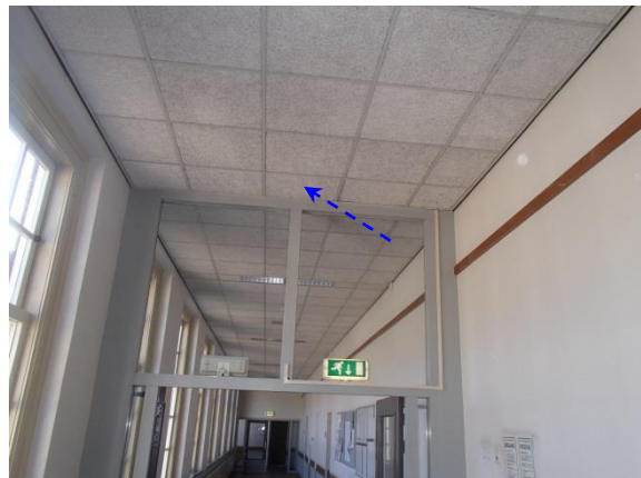
Foto 02: 2 e etage, gang t.h.v. 205, boven kozijn M01 vlakke plaat - Asbestvrij
