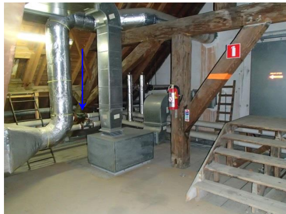
Foto 20: zolder, leidingen M12 pakking - Asbestvrij
