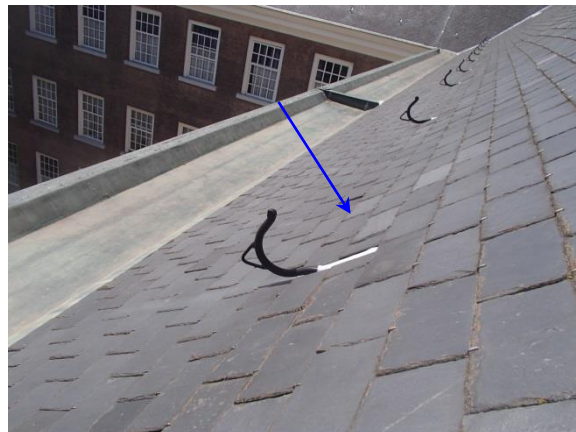
Foto 08: dak M05 dakleien - Asbestvrij
