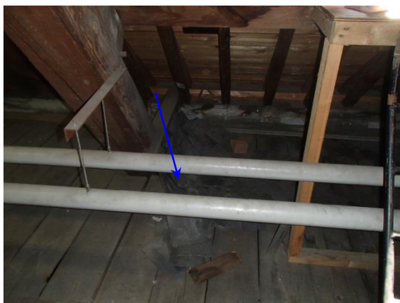
Foto 09: zolder, restanten V04 dakleien - Asbestvrij
