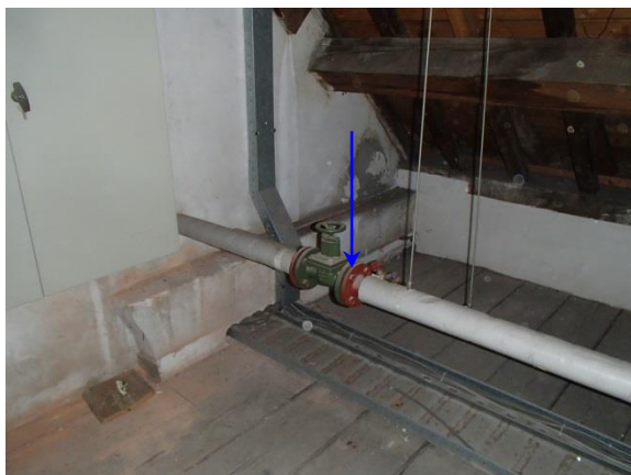
Foto 19: zolder, leidingen M11 pakking - Asbestvrij
