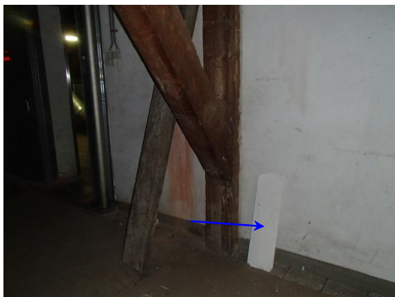
Foto 25: zolder, houten vloer V15 vlakke plaat - Asbestvrij
