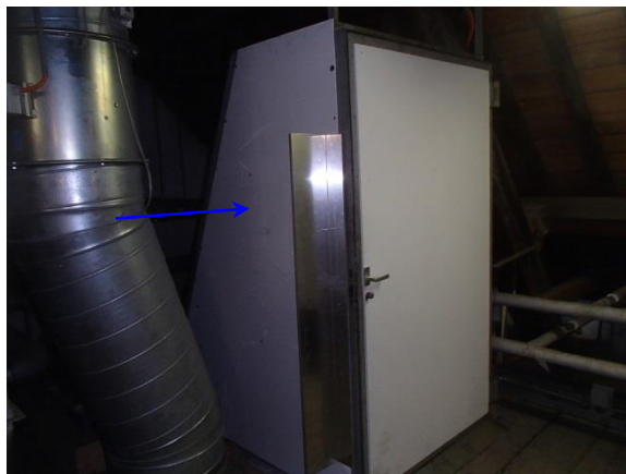
Foto 16: zolder, trappenhuis rondom en binnenzijde M08 vlakke plaat - Asbestvrij
