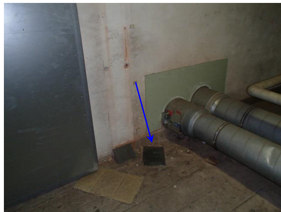
Foto 10: zolder, restanten V05 dakleien - Asbestvrij
