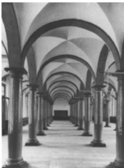
afb. 16 de voormalige open hal gezien vanuit het noorden met links de toegang naar de binnenhof (foto RDMZ, G. de Hoog, 1906).
