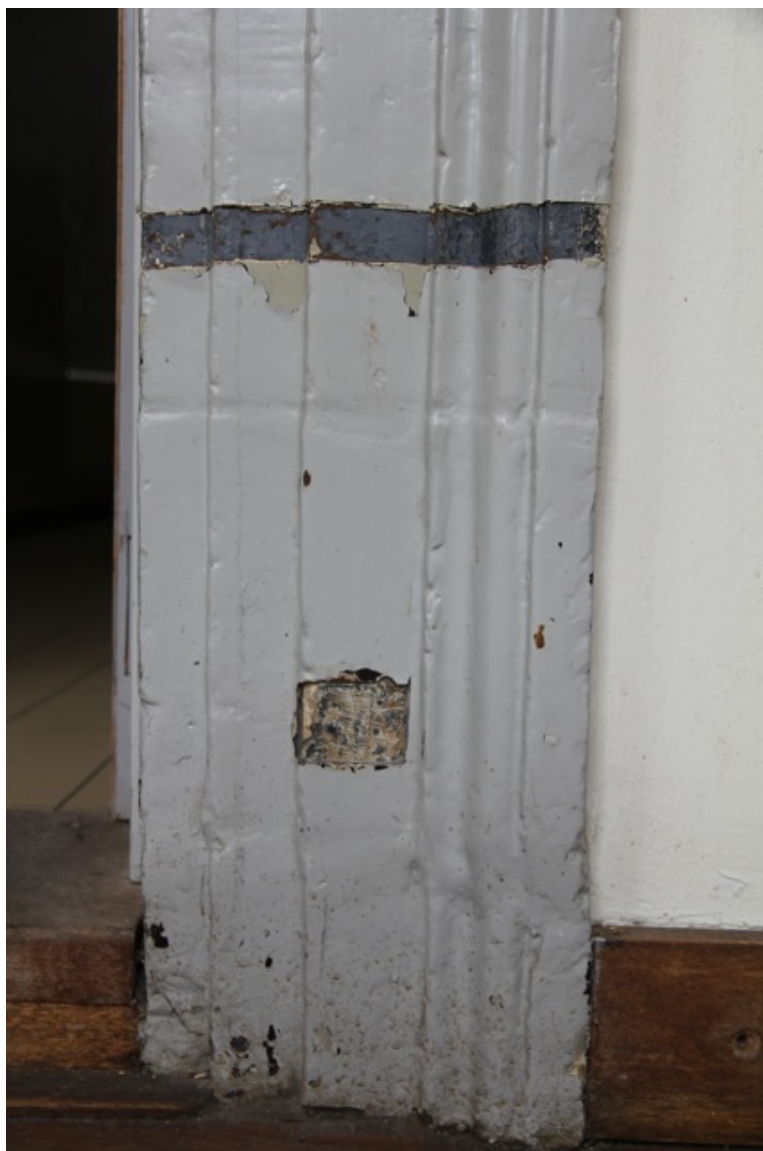
afb. 13 De vergrijsde blauwe laag 1 vrijgelegd over de breedte van de lijst met de donkere nuances
