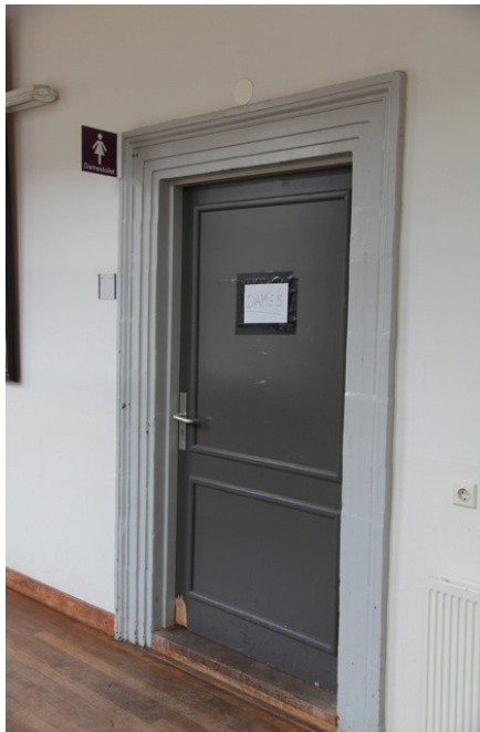
afb. 9 deurlijst ten westen van het N.O. bordestrappenhuis
