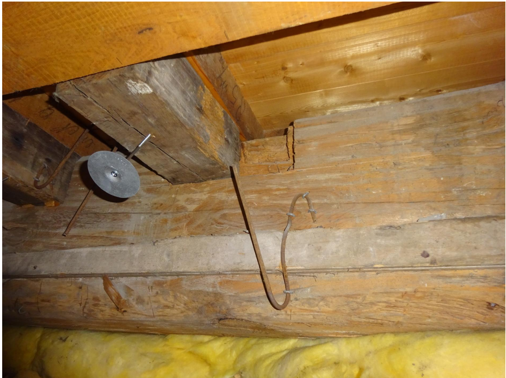
Aanzicht boven het plafond
