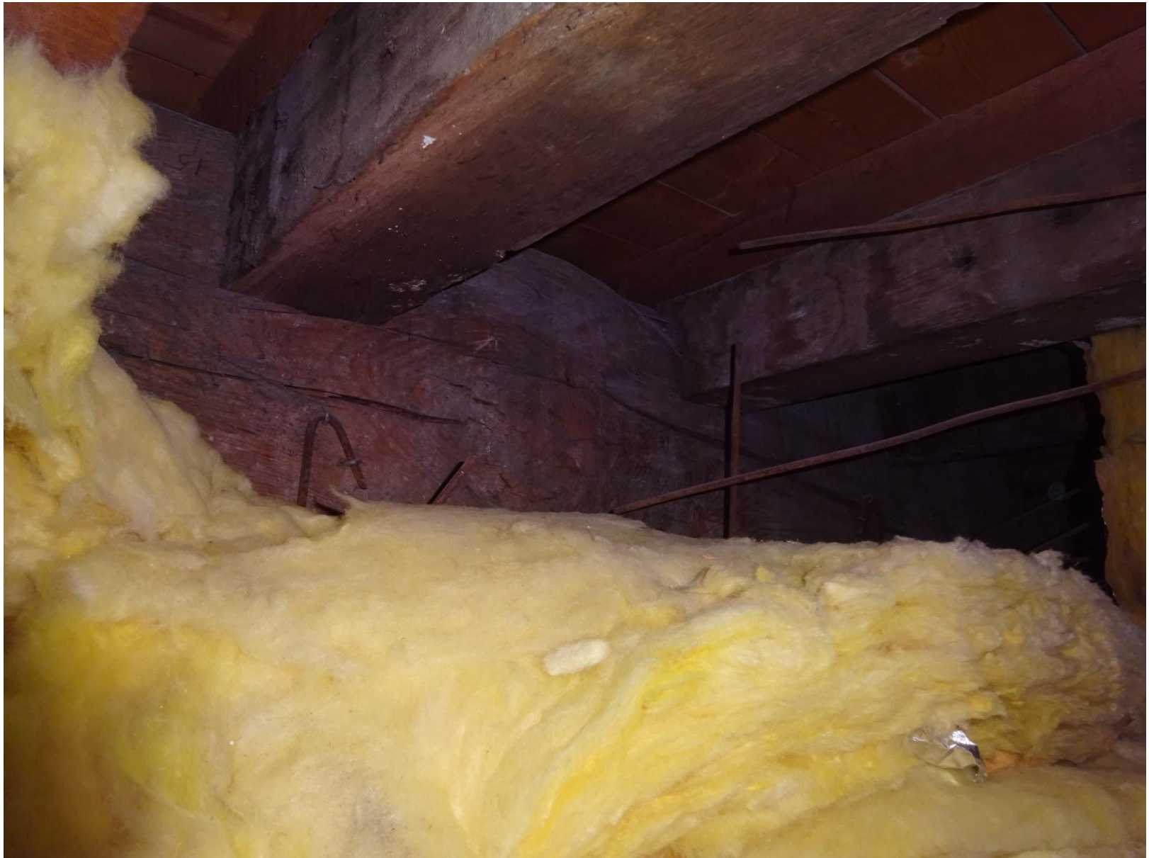
Aanzicht boven het plafond
