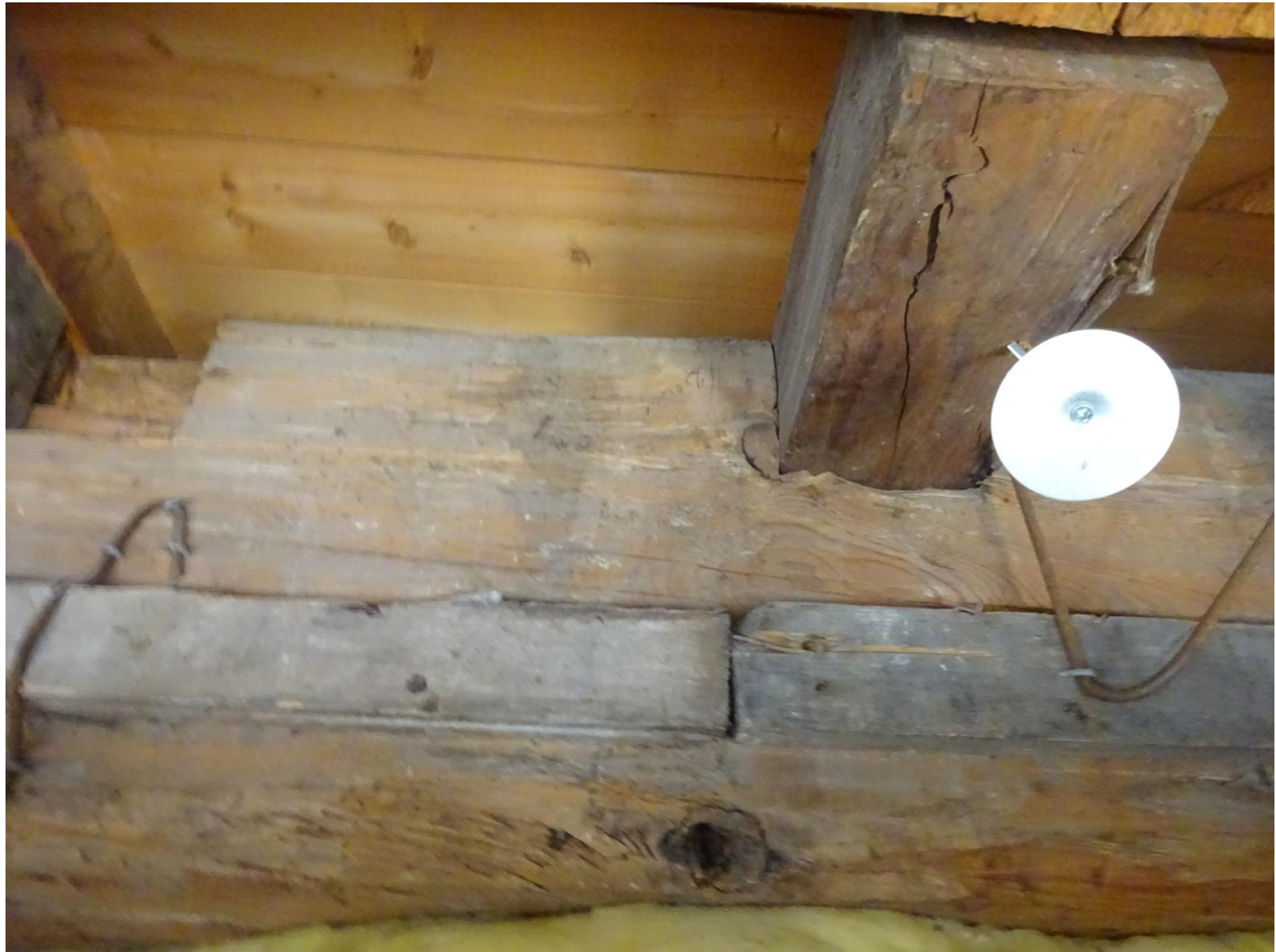
Aanzicht boven het plafond
