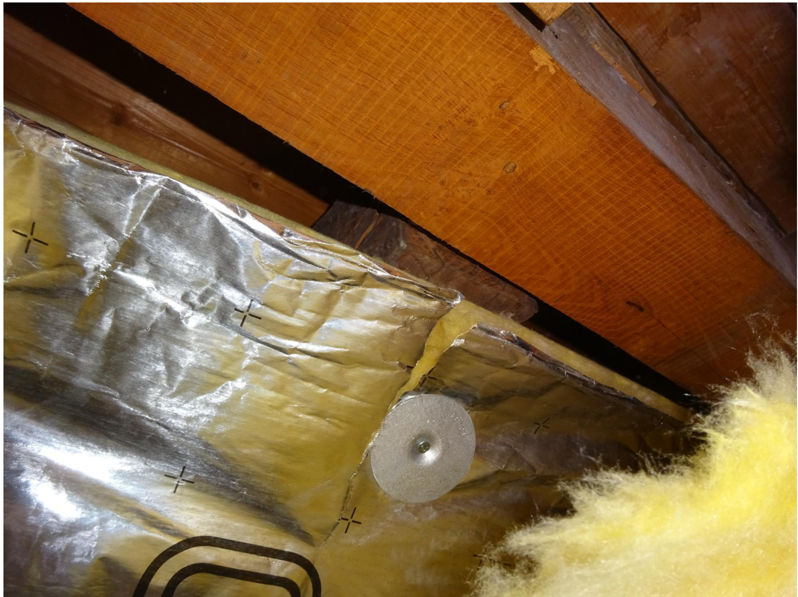
Aanzicht boven het plafond
