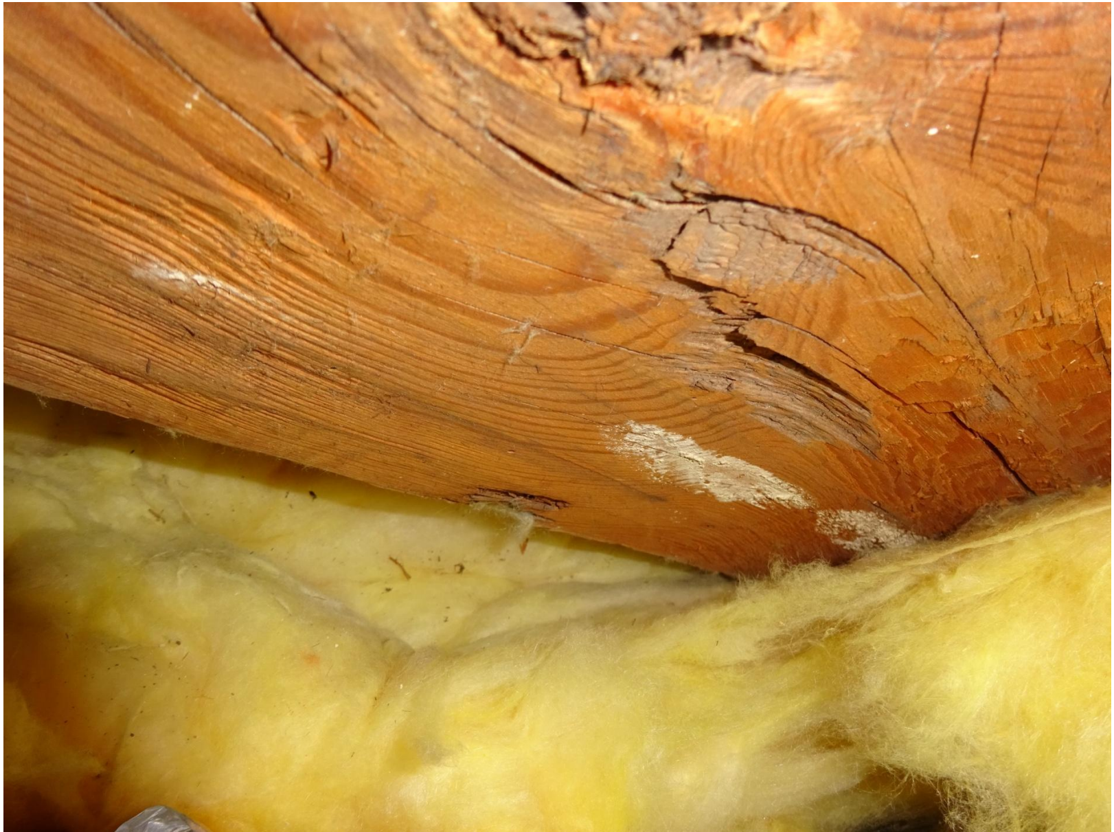
Aanzicht boven het plafond
