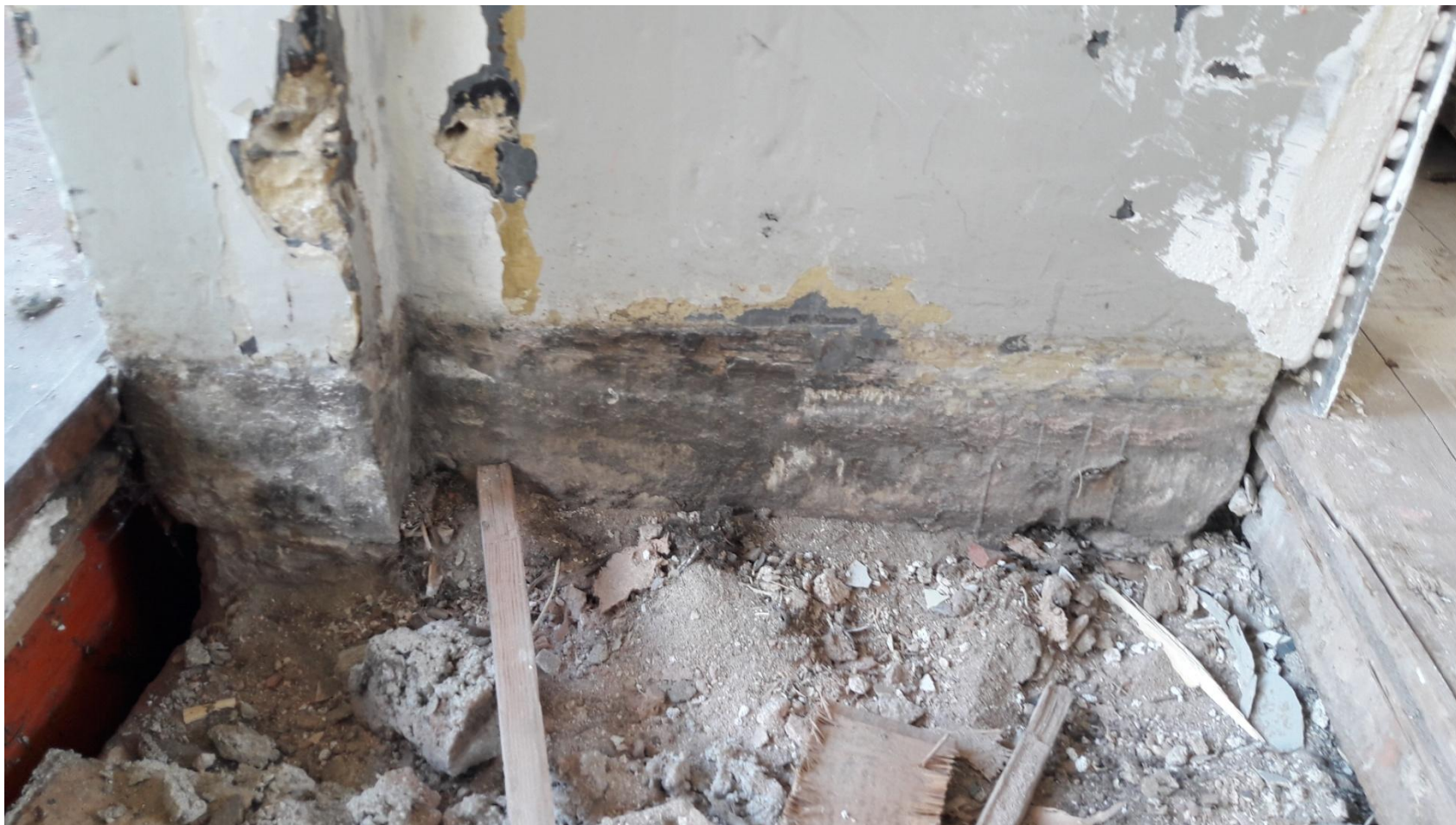
Aanzicht van natuursteen kozijnkader met metselwerk onderconstructie
