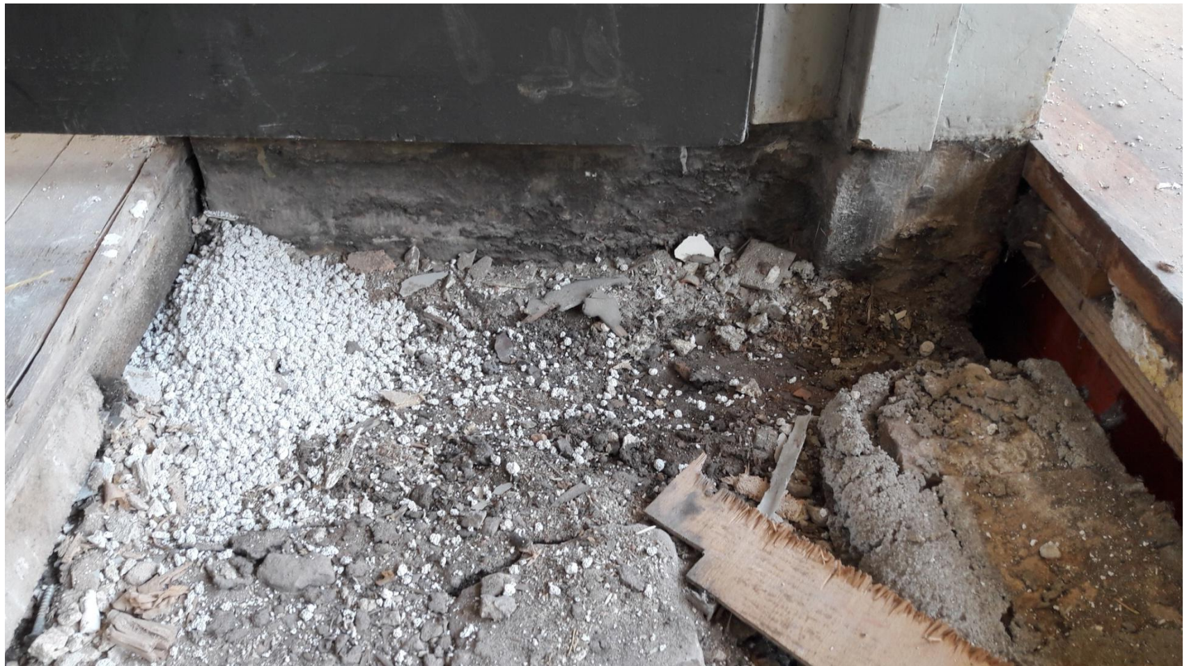
Aanzicht van natuursteen kozijnkader met metselwerk onderconstructie
