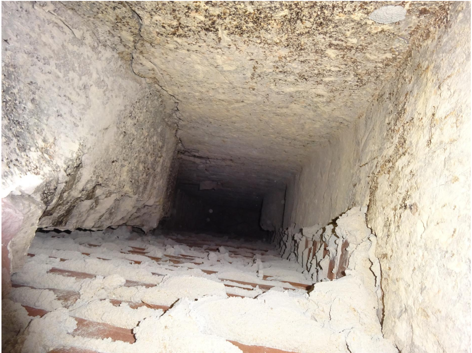
Vloeropening historische schouw
