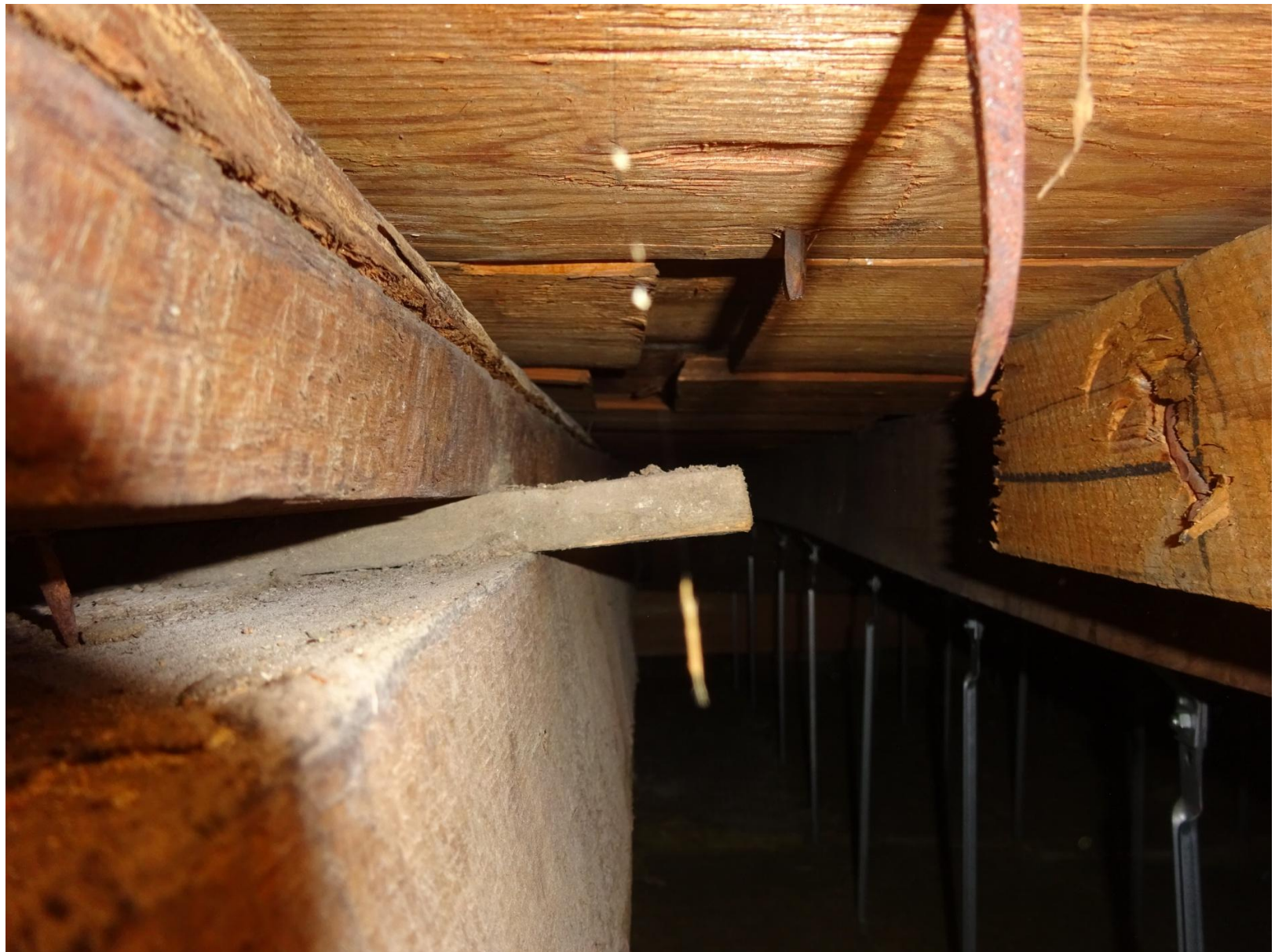
Aanzicht onder de vloer
