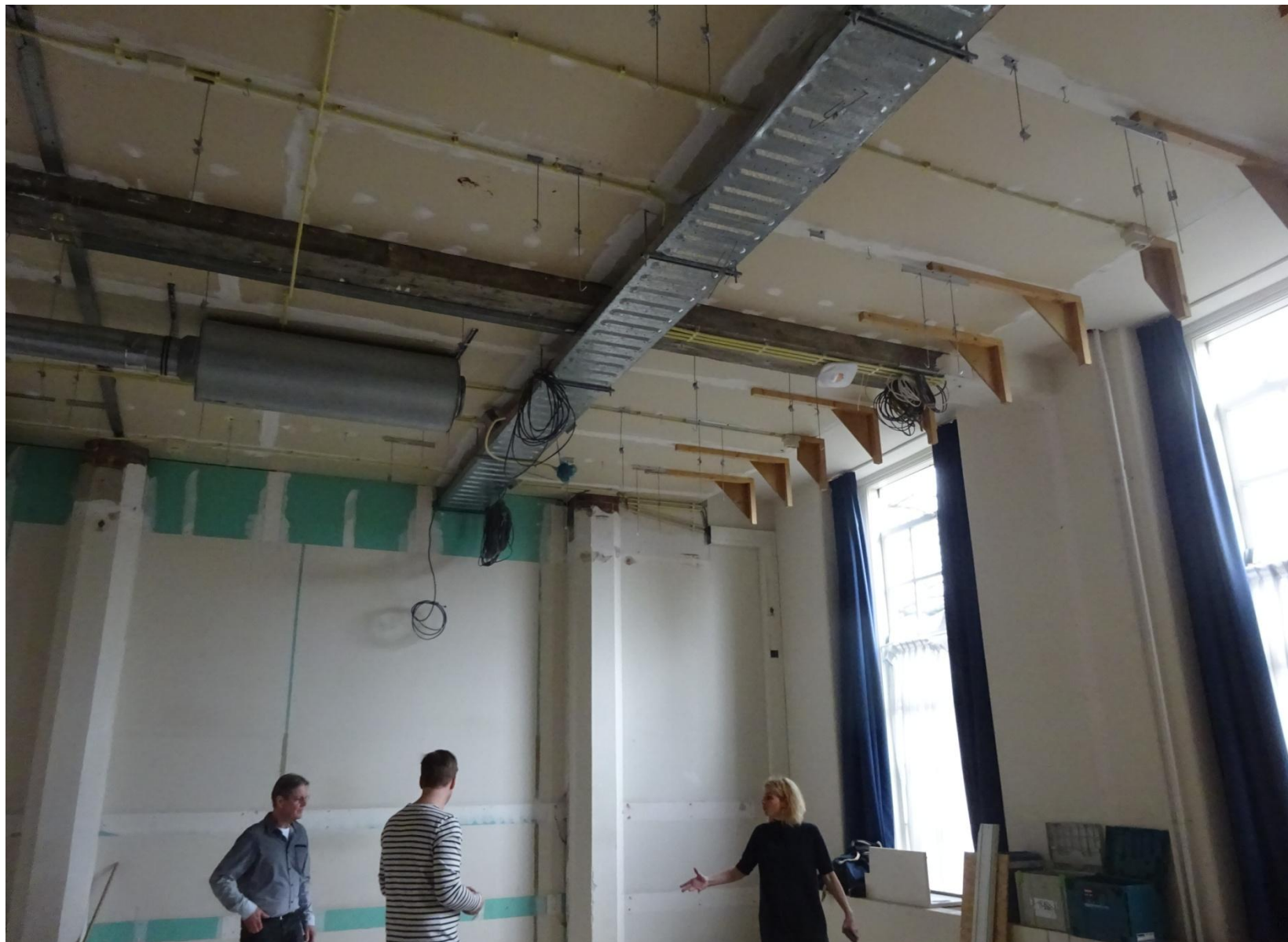
Bestaande installaties en aansluitingen boven systeemplafonds
