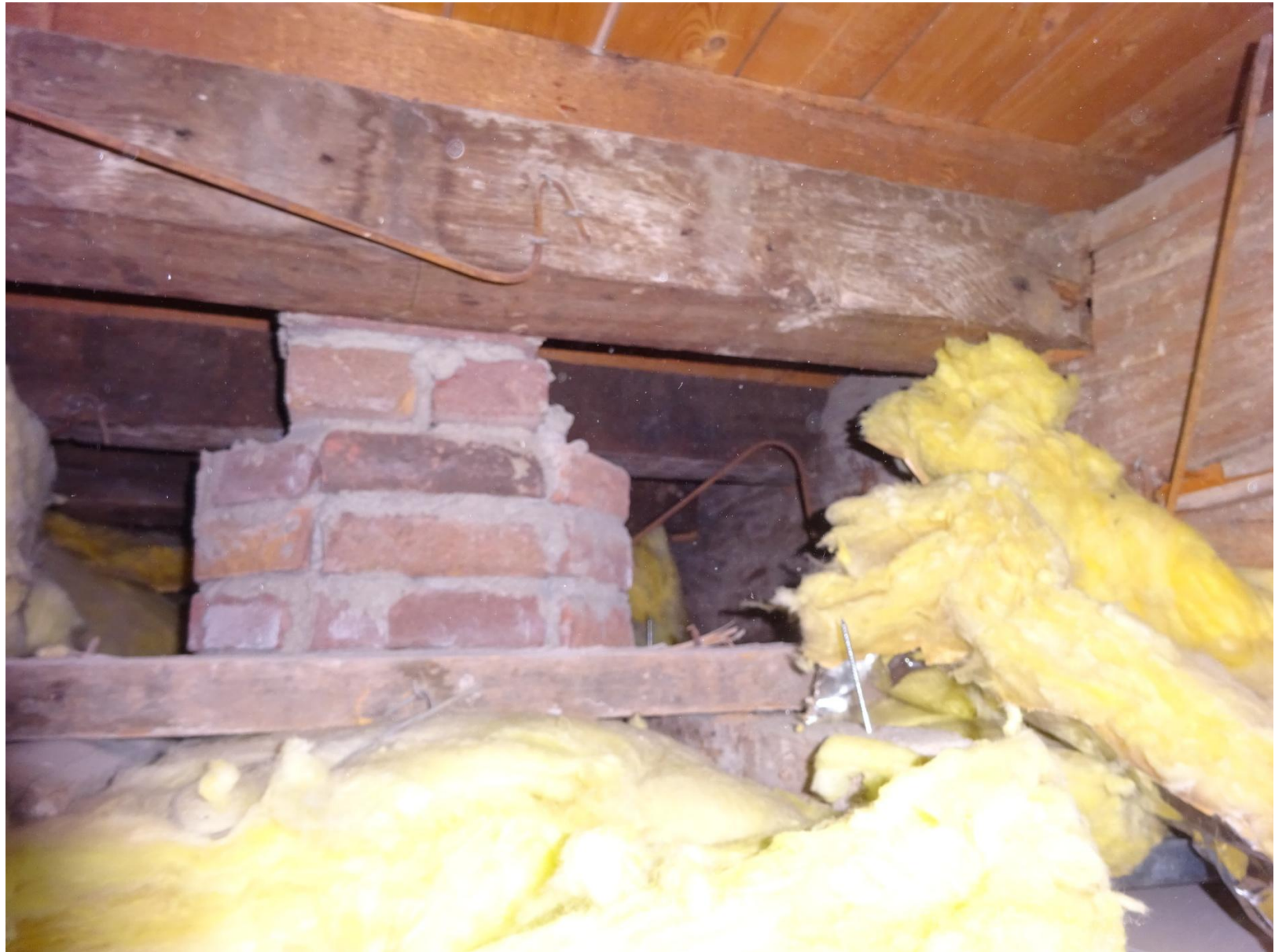
Aanzicht boven het plafond
