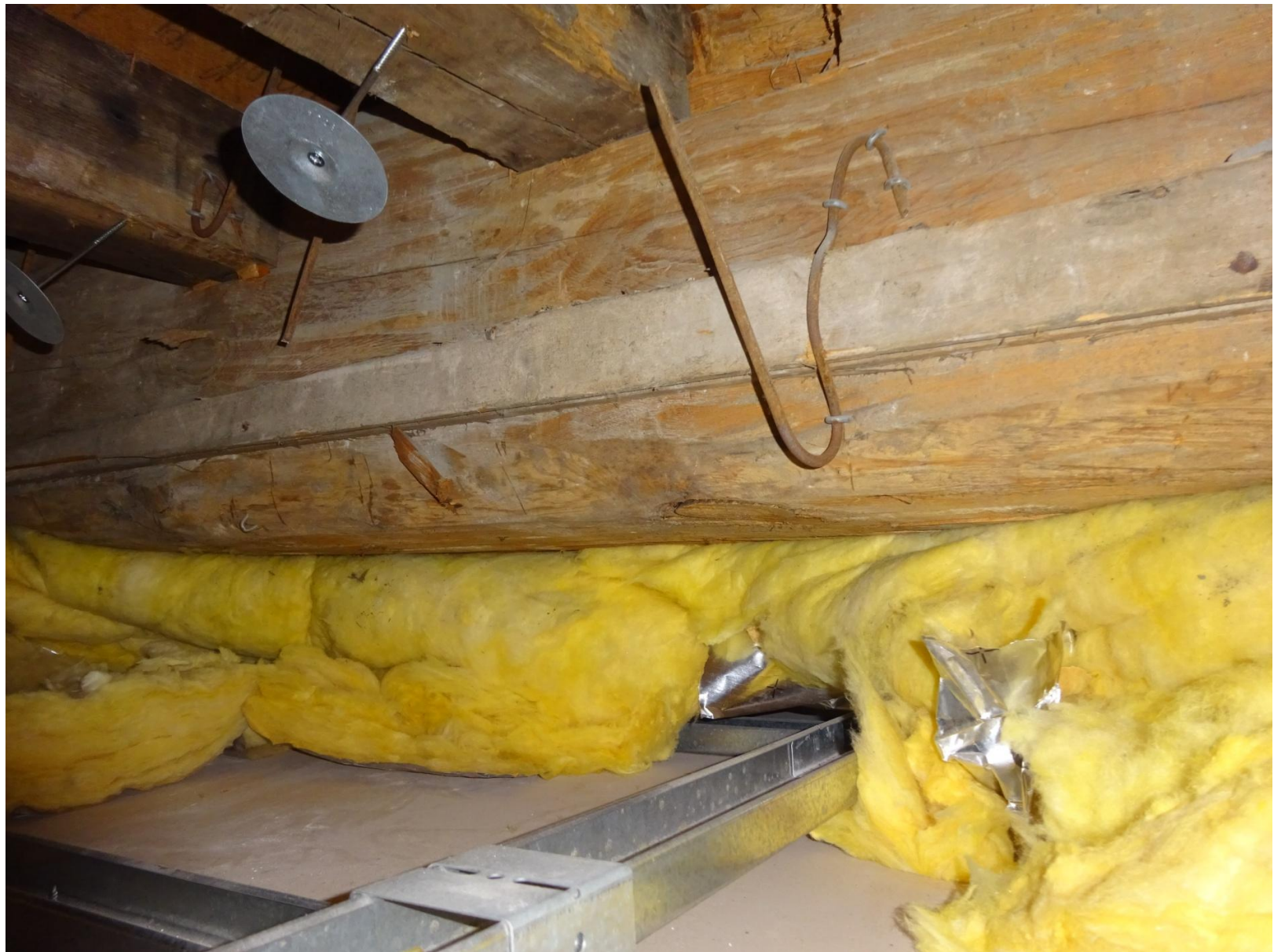
Aanzicht boven het plafond
