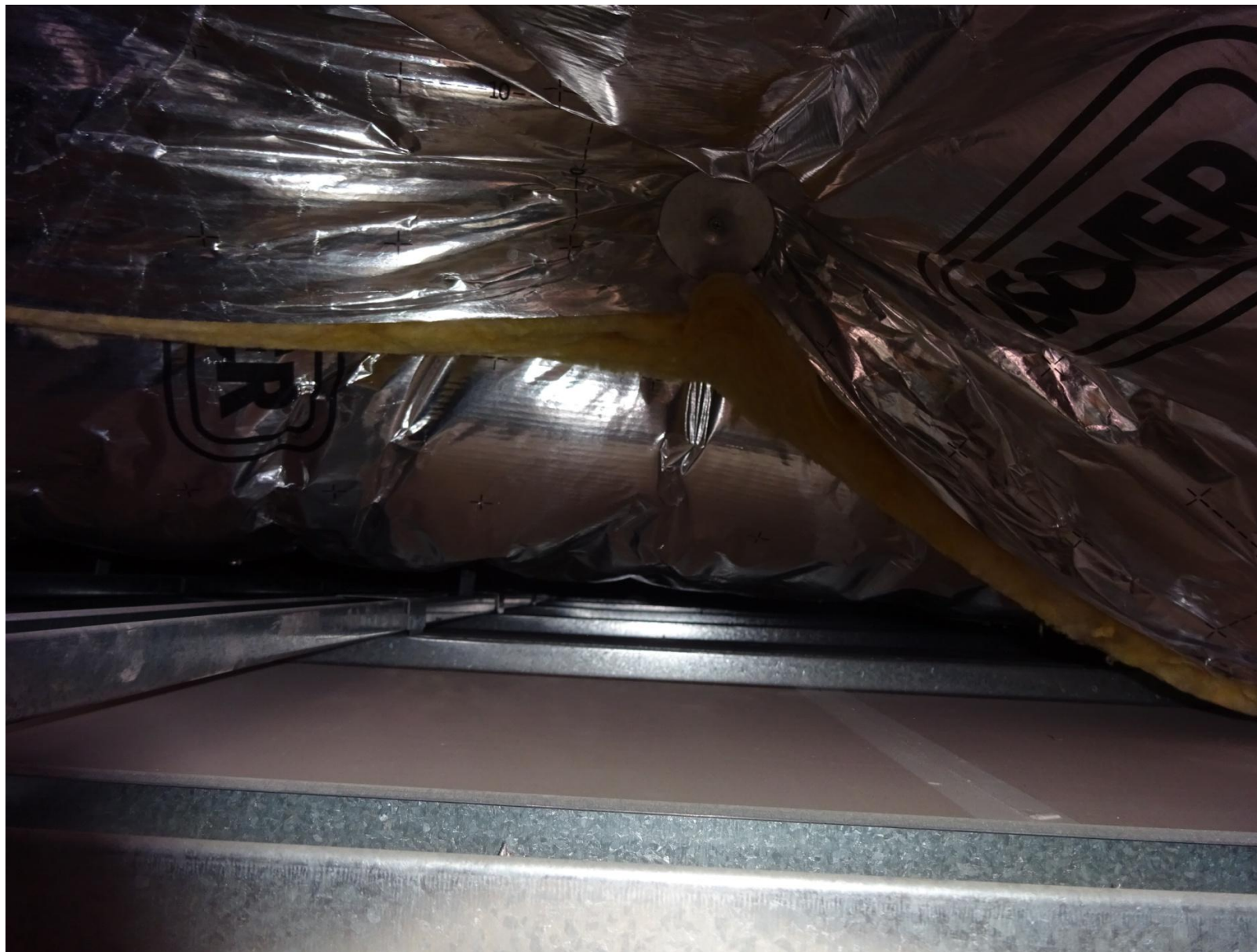
Aanzicht boven het plafond
