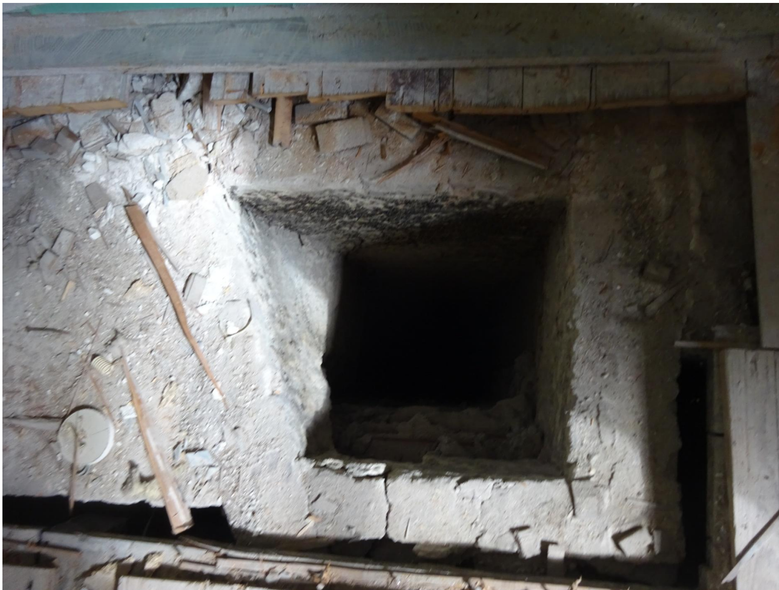
Vloeropening historische schouw
