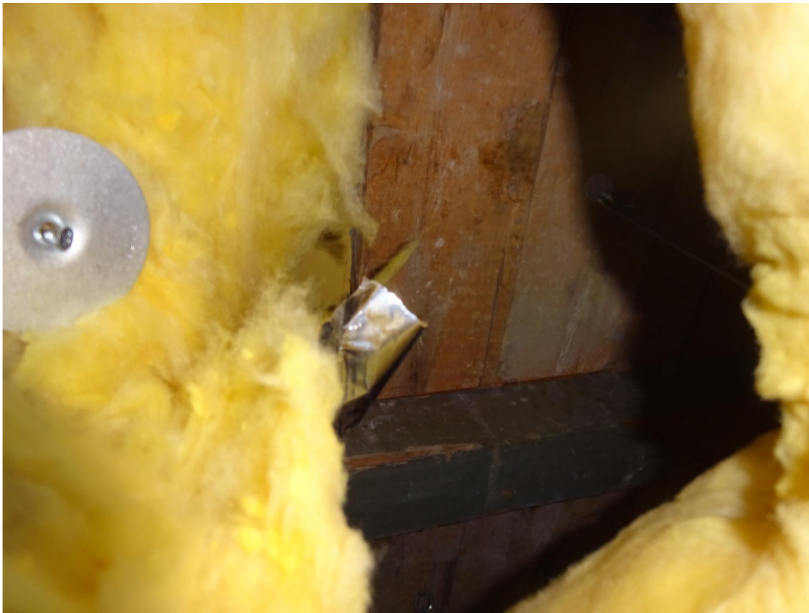
Aanzicht boven het plafond
