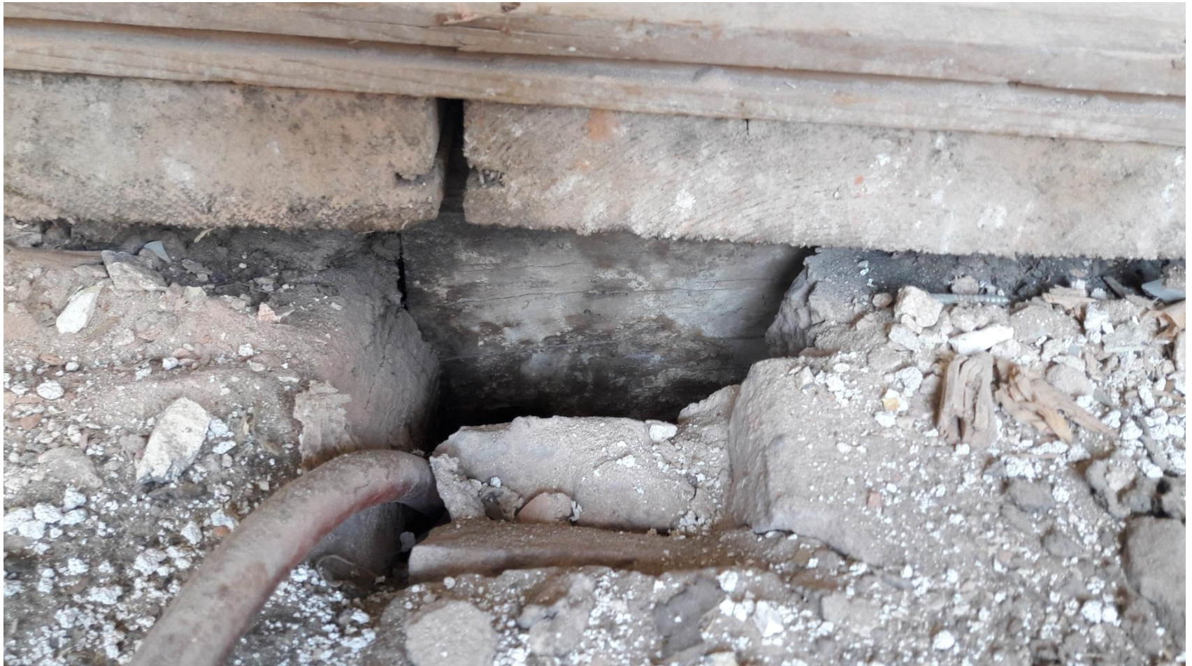
Aanzicht vanuit gangzone onder vloeren legeringskamer
