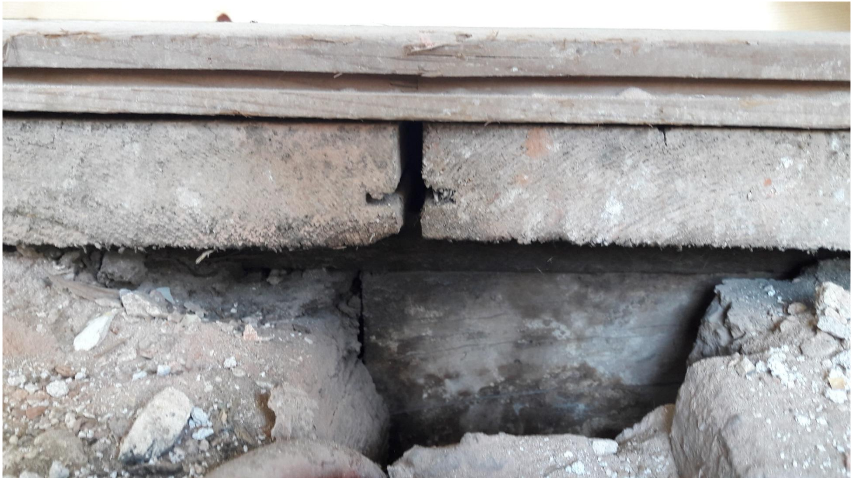
Aanzicht vanuit gangzone onder vloeren legeringskamer
