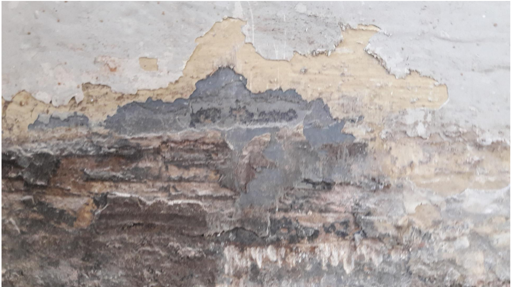
Detail verflagen en opbouw natuursteen kozijnkader
