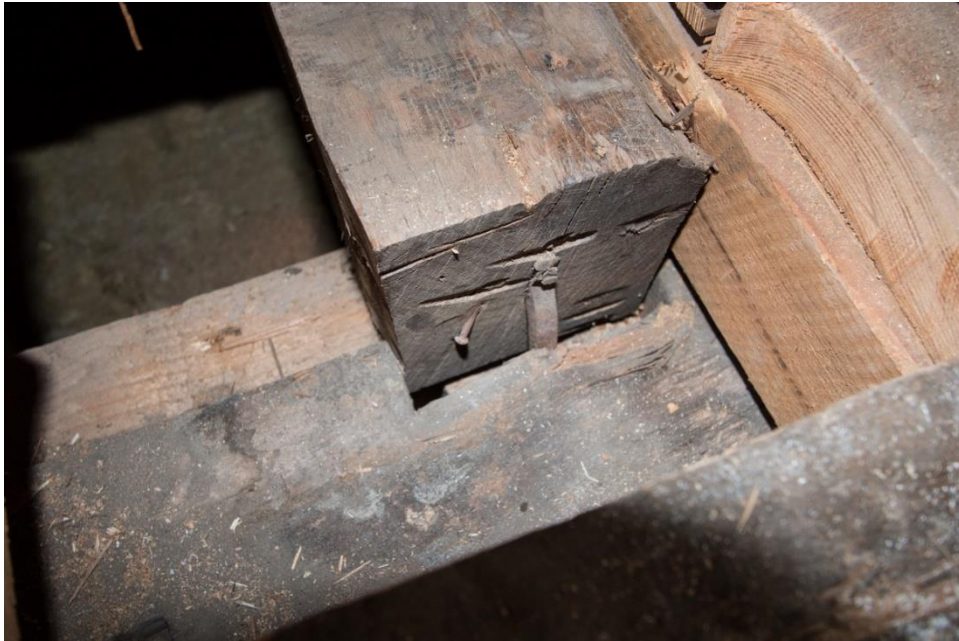
Afbeelding: Kinderbint steekt nu boven de moerbalk uit. Gesmede spijker is daarbij behouden gebleven. Dat de ingreep vermoedelijk in 1948 werd uitgevoerd, is aannemelijk op basis van een modern spijkertje in de kop van de bint.
