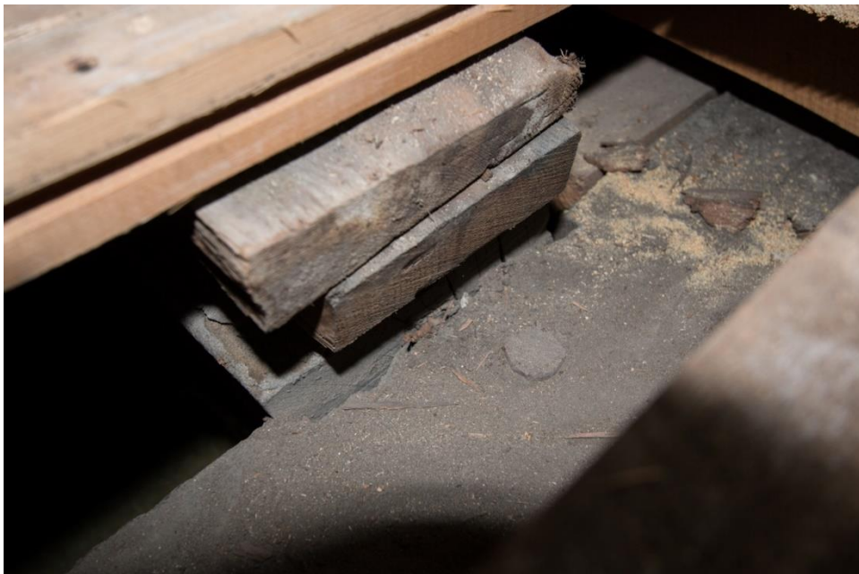
Afbeelding: Uitvlakken van de vloer middels stelklosjes boven de dwarsbalk. Op de foto ook de toognagel van de gepende verbinding tussen moerbalk en dwarsbalk.
