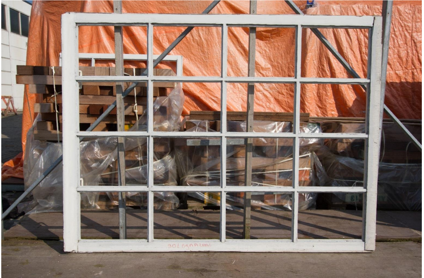
Onderraam op de zijkant gezet (links de weldorpel aan de onderzijde. Het raam is met de buitenzijde naar de fotograaf gekeerd. Raamhout en roeden zijn hier niet geprofileerd in verband met de glassponning.
