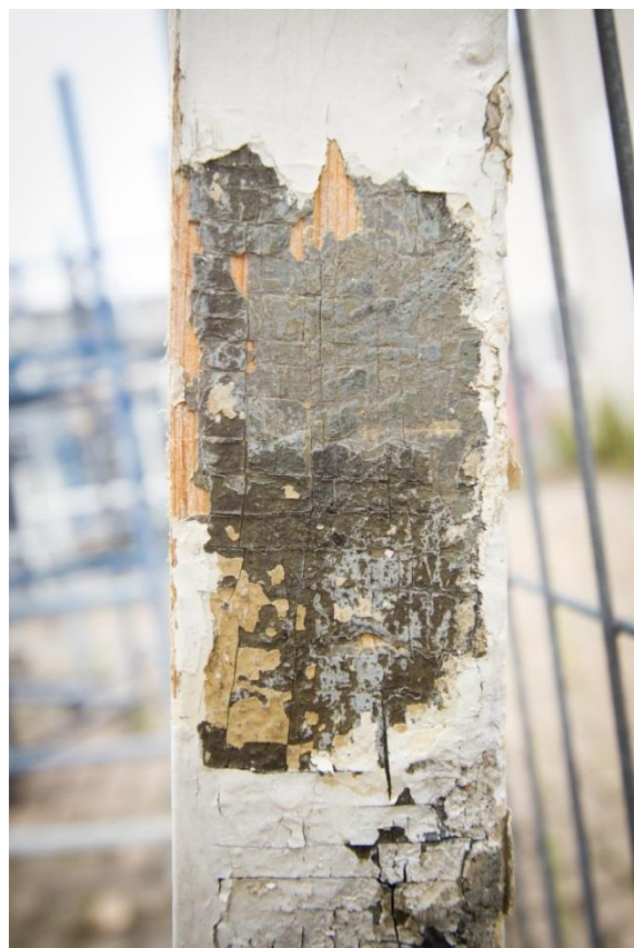
Detail van het scharnierpunt van het tuimelraam, net boven de pen van de dwarsroede. Oude verflagen op één van de raamhouten van het tuimelraam. De oudste aanwezige kleur in groen.
