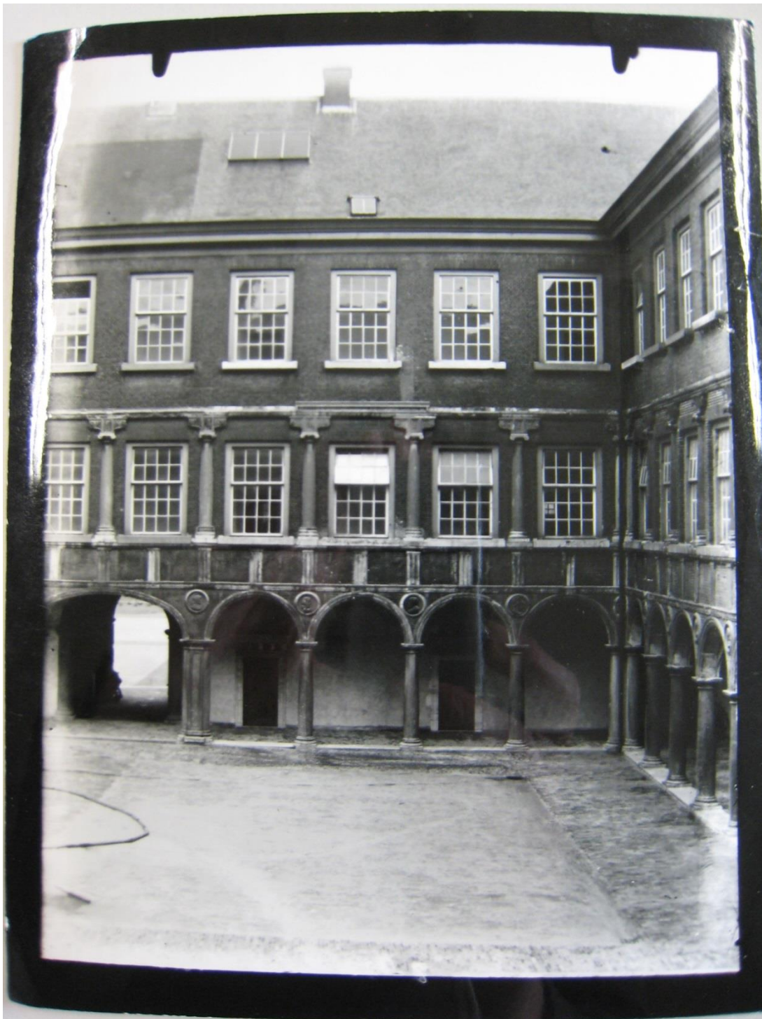
De oostgevel heeft op de tweede verdieping schuivende bovenramen. Alle overige bovenramen zijn, voor zover valt af te lezen, kantelend uitgevoerd.
