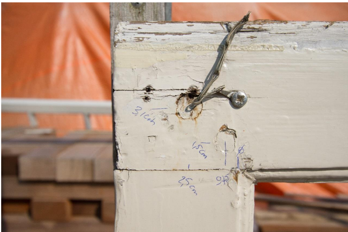
Onderraam hoekverbinding raamhout, gezekerd met toognagels. Profilering aan de binnenzijde van het raam.
