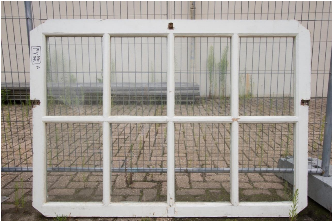
Het gedocumenteerde tuimelraam in overzicht. Hoeken waren reeds afgezaagd. Dit is bij het maken van de documentatietekeningen genegeerd.
