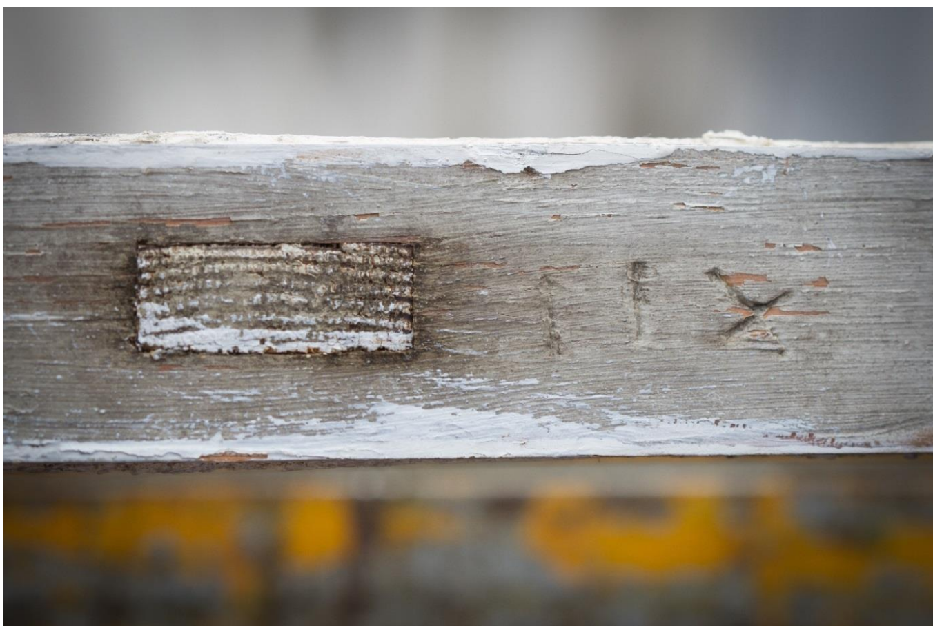
Detail van één van de raamhouten van een onderraam met bij de pen van een roede het gehakte merk IIX.
