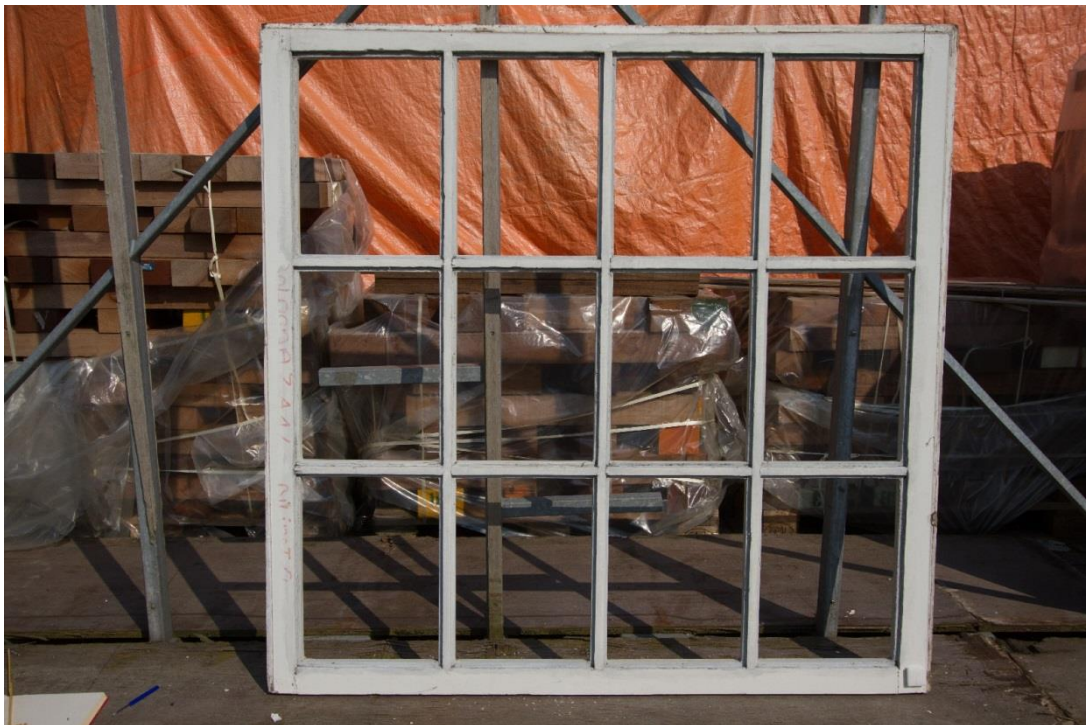
Binnenzijde (boven, geprofileerd) en buitenzijde (onder met glassponning) van een bovenraam.
