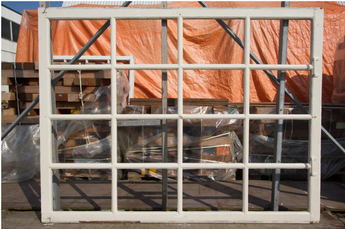
Onderraam op de zijkant gezet (rechts de handgrepen op het raam open te schuiven, onderzijde). Het raam is met de binnenzijde naar de fotograaf gekeerd. Raamhout en roeden zijn hier geprofileerd.
