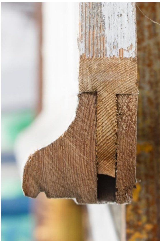
Onderdorpel van één van de negentiende-eeuwse onderramen, oorspronkelijk schuivend uitgevoerd.
