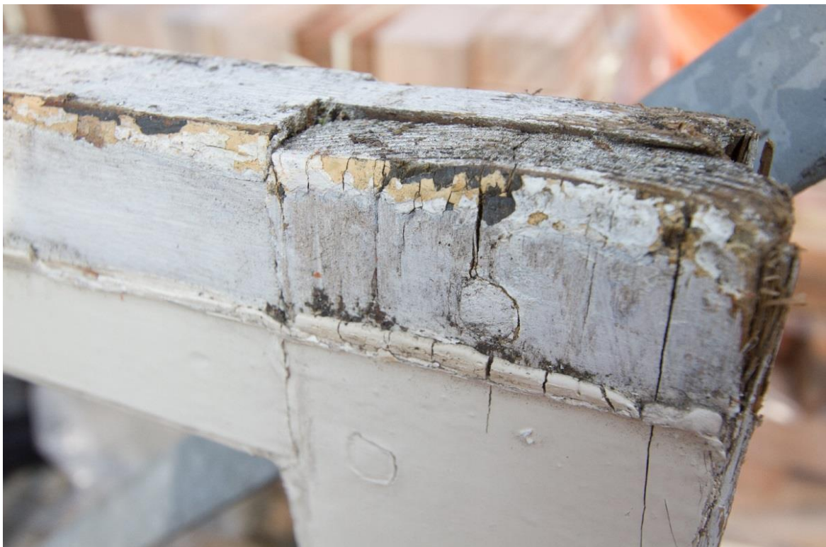
Hoekverbinding van het raamhout, ook hier met een groene kleur als eerste afwerklaag.
