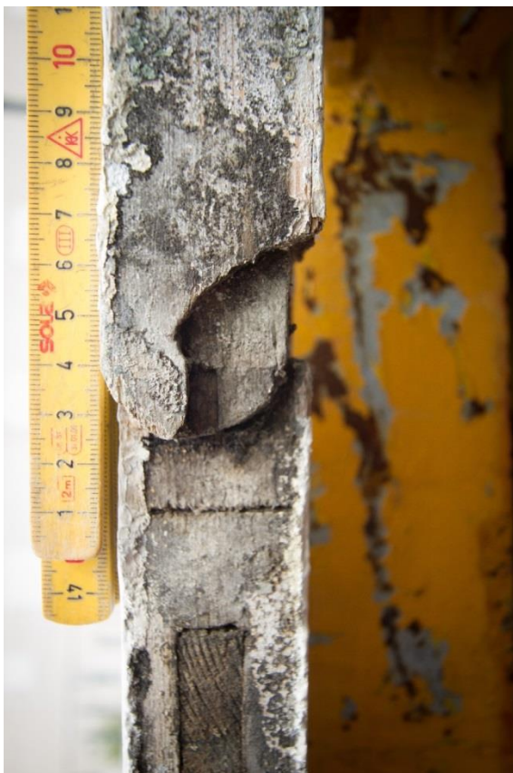
Detail van het scharnierpunt van het tuimelraam, net boven de pen van de dwarsroede. Oude verflagen op één van de raamhouten van het tuimelraam. De oudste aanwezige kleur in groen.
