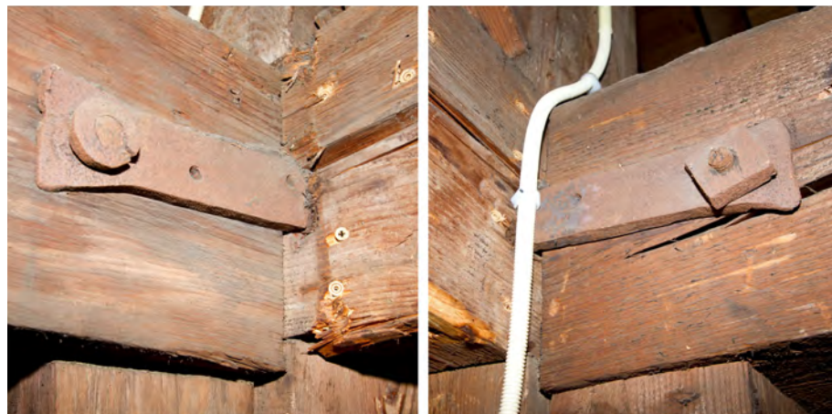
Afb. 41 Details van de verandering van de haaks op elkaar gerichte spanten, met negentiende-eeuwse ankers, bout en de, voor de tijd typische, vierkante moer.
