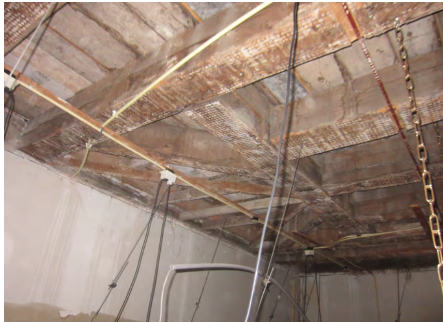
Afb. 91 Deel van de zeventiende-eeuwse, enkelvoudige balklaag van de verdiepingsvloer, gefotografeerd boven het verlaagde plafond in ruimte 4, het vertrek grenzend aan het trappenhuis. De raveelconstructie diende een rookkanaal dat is verdwenen. De diagonale balken zijn in de achttiende eeuw aangebracht op het moment dat het vertrek in twee werd gesplitst.
