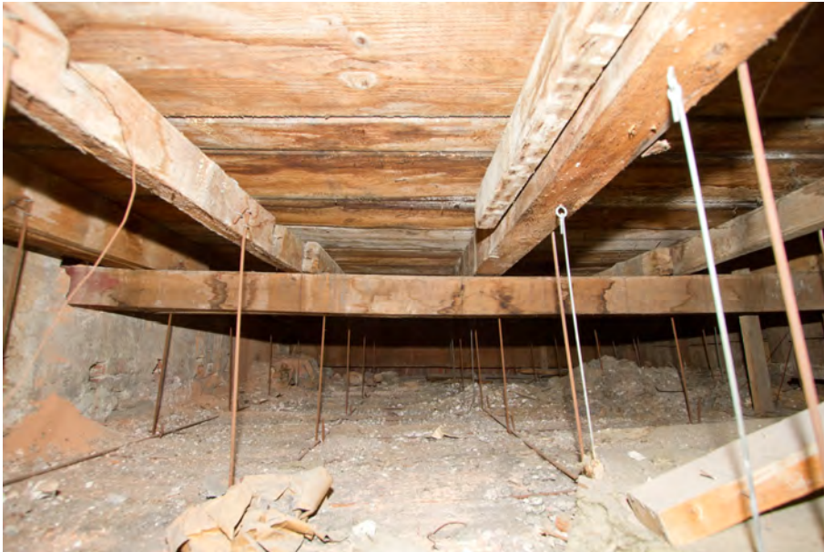
Afb. 64 De westvleugel nabij de noordelijke kopgevel, gezien in zuidelijke richting onder de zoldervloer. Hier zien we een steengaasplafond met ijzeren frame, gehangen aan ijzeren beugels die aan de vloerbinten zijn genageld. Deze constructie leidt tot minder scheurvorming in het plafond in vergelijking met stucplafonds op houten balken. Het steengaasplafond is vermoedelijk aangebracht in de periode 1948-1950 toen de stalen balken en portalen onder de negentiende-eeuwse moerbalken werden aangebracht.
