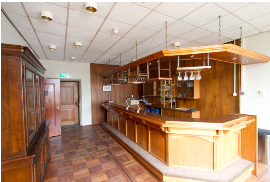
Afb. 90 Bar met een verlaagd plafond (ruimte 4) waarboven een nog zeventiende-eeuwse balklaag schuil gaat.
