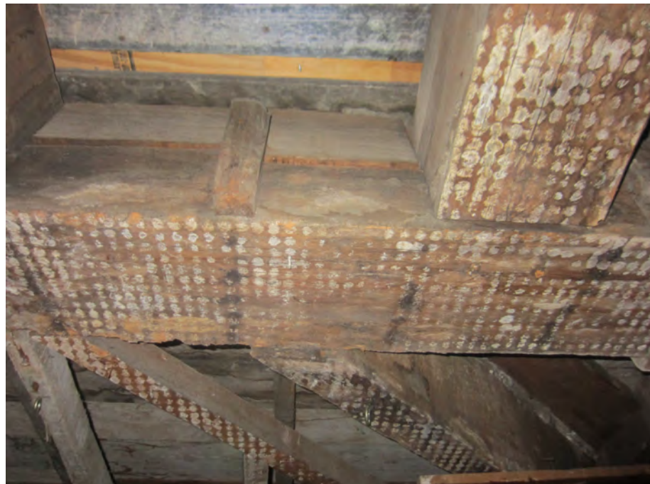
Afb. 92 Op de balklaag sporen van een verdwenen stucgaasplafond. De donkere ronde afdrukken op de balken zijn van spijkerreeksen, mogelijk in verband te brengen met een verdwenen plafond van hout. Ruimte 4.
