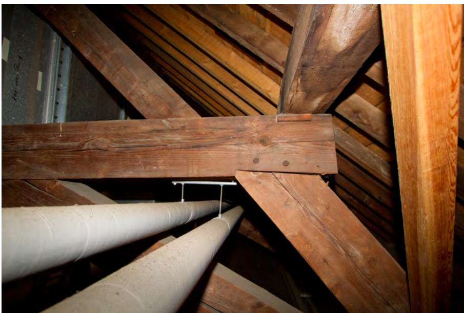
Afb. 38 De westvleugel en de spantvormen die daar voorkomen. Om de dakvorm mogelijk te maken zijn asymmetrische spanten haaks op de kopgevels toegepast.
