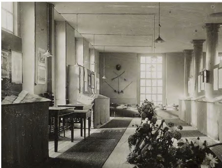
Afb. 130 Opname uit 1928 waarop de gaslampen zijn verdwenen en elektrisch licht zijn intrede heeft gedaan. De elektrische leidingen zijn over het plafond naar de randen geleid. Opname gemaakt ten behoeve van een tentoonstelling in het kader van het honderdjarig bestaan van de Koninklijke Militaire Academie.
