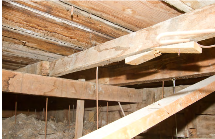
Afb. 71 Er zijn drie balken aangebracht tussen de kopgevels en de eerste moerbalken. Op deze foto is te zien hoe in één van deze balken een onderslagbalk is opgelegd ter ondersteuning van de binten.
