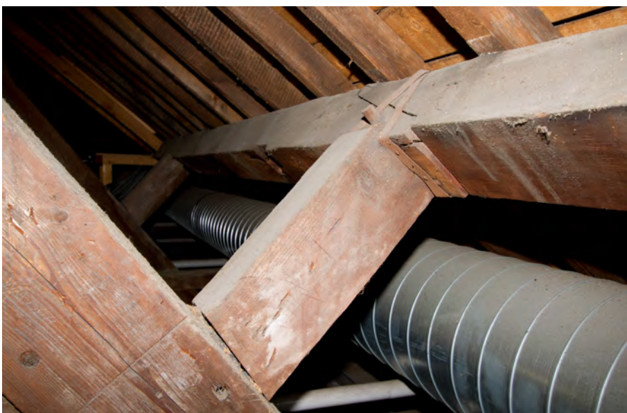
Afb. 40 Aan de westzijde zijn langere klossen nodig om de onderste flieringen verder naar van de spantbenen af te brengen. Dit in verband met de hogere borstwering aldaar.
