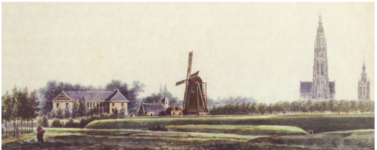
Afb. 128 De militaire academie in aanbouw in 1828. Het dak van de noordelijke zijvleugel is nog niet geheel met leien bedekt.
