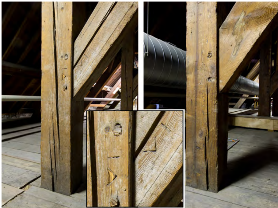
Afb. 14 Onderscheid in de merkmethode op de spanten van de noordvleugel. Een deel van de spanten heeft aanmerkelijk meer merken gekregen. Dit is het beste te zien waar het korbeel aansluit op de standvinkstijl. De betreffende merken (VI in dit geval) zijn in uitsnede vergroot weergegeven.
