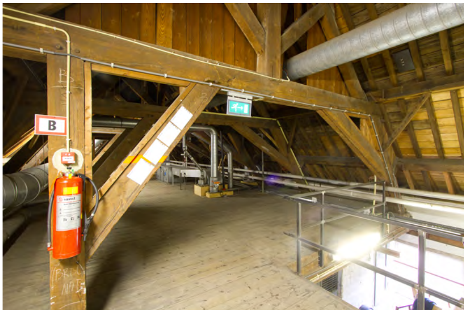
Afb. 10 Het spant bij het trapgat, gemerkt XVII. Op veel van de spanten zijn inscripties en opschriften te vinden teruggaande tot in de negentiende eeuw. Boven de dekbalk een restant van een beplanking. De zolders hebben in de loop der tijd een aantal functies gehad. Thans dienen ze louter voor het opstellen van technische installaties.
