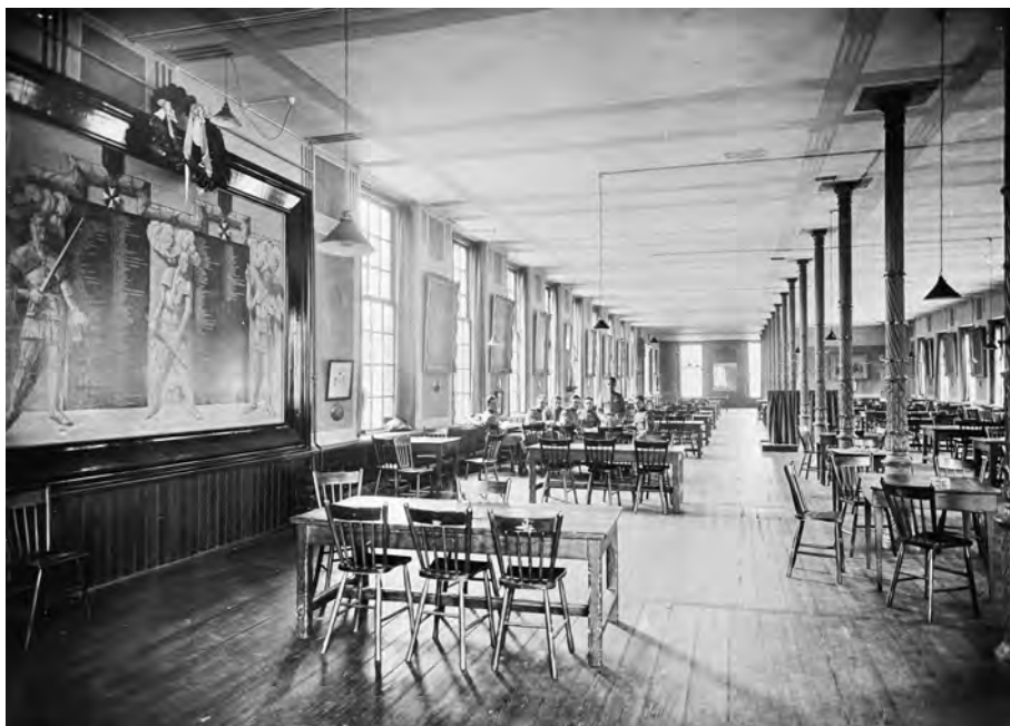
Afb. 53 Opname in de ontspanningszaal op de eerste verdieping van de westvleugel. Kolommen van gietijzer, vlak plafond met schildering en vloerdelen gelegd in de lengterichting van de vleugel. Bron: RCE 352515.
