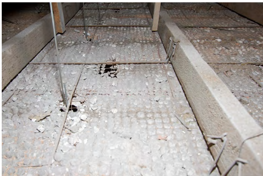
Afb. 66 Op deze opname is het vierkante draadraster dat de basis voor het steengaasplafond op de tweede verdieping (westvleugel) vormt, goed te zien. Op sommige plaatsen is het raster met ijzerdraad gelust aan plafondbalken.
