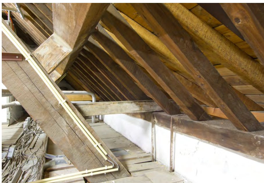
Afb. 150 In detail de dakvoet. De muurplaat is verankerd aan de moerbalk. De spanten zijn door middel van blokkeels (enkele zijn vernieuwd) aan de muurplaat gezet. De negentiende-eeuwse sporen zijn fijn bezaagd.
