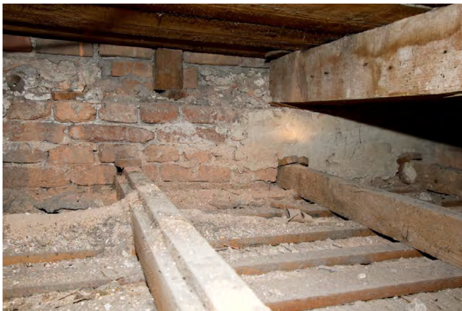
Afb. 85 Documentatie van de balklaag van de zoldervloer, de vloerdelen en een reconstructie van de opdeling in vloervelden zoals in 1827-1828 werd gerealiseerd. De regmaat van de balklaag werd aangepast bij het trapgat en bij de rookkanalen. Bij vloerveld 3 werden in 1827-1828 ook vloerdelen hergebruikt. De overige delen zijn primair (1827-1828).
