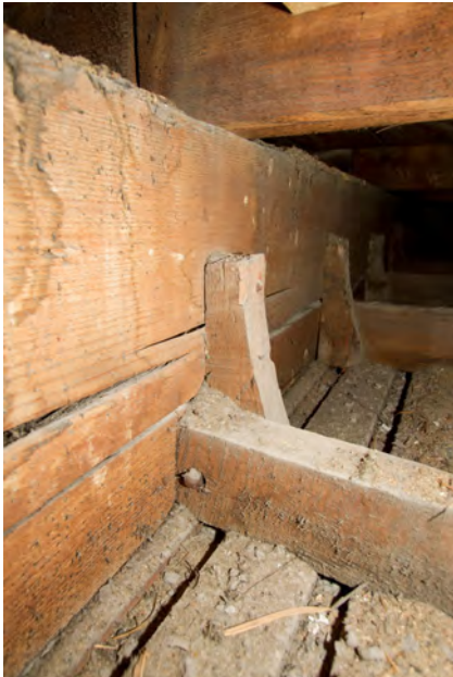
Afb. 119 Opname boven het plafond in één van de kamers op de tweede verdieping. De foto toont onder andere het rachelwerk waartegen aan de onderzijde riet is aangebracht als drager voor het stucplafond. Het rachelwerk is gespijkerd aan plafondbalken die met behulp van klossen bevestigd zijn aan de moerbalken.
