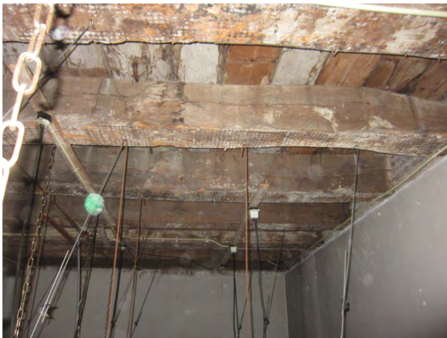
Afb. 93 Waar in de achttiende eeuw een binnenmuur werd geplaatst, zijn de balken het sterkst verweerd. Zo is op de balken de achttiende-eeuwse structuur nog te herleiden. Ruimte 4.
