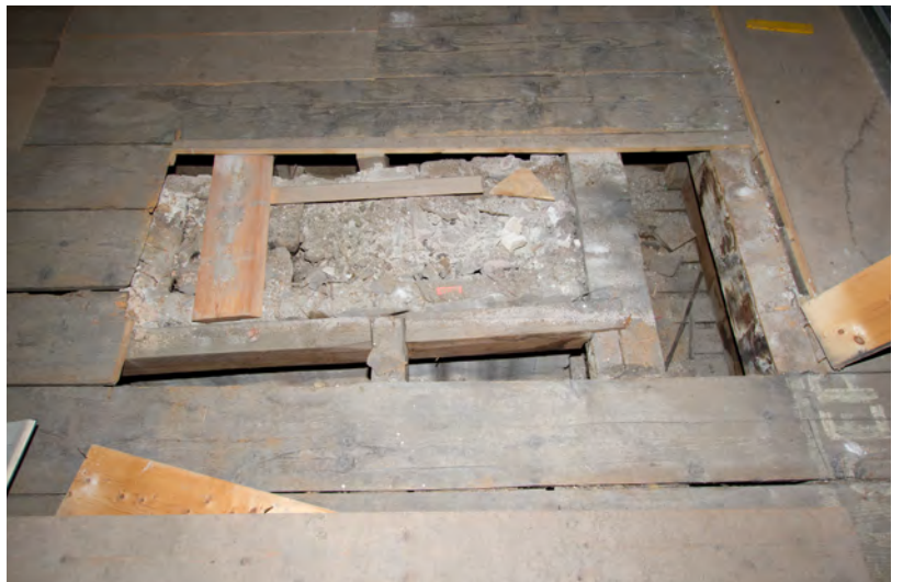
Afb. 122 De zolder van de tweede verdieping toont in de vloerdelen dichtzettingen daar waar tot 1948-1950 rookkanalen hebben gezeten. Hier een raveelconstructie en een restant van een van deze rookkanalen.
