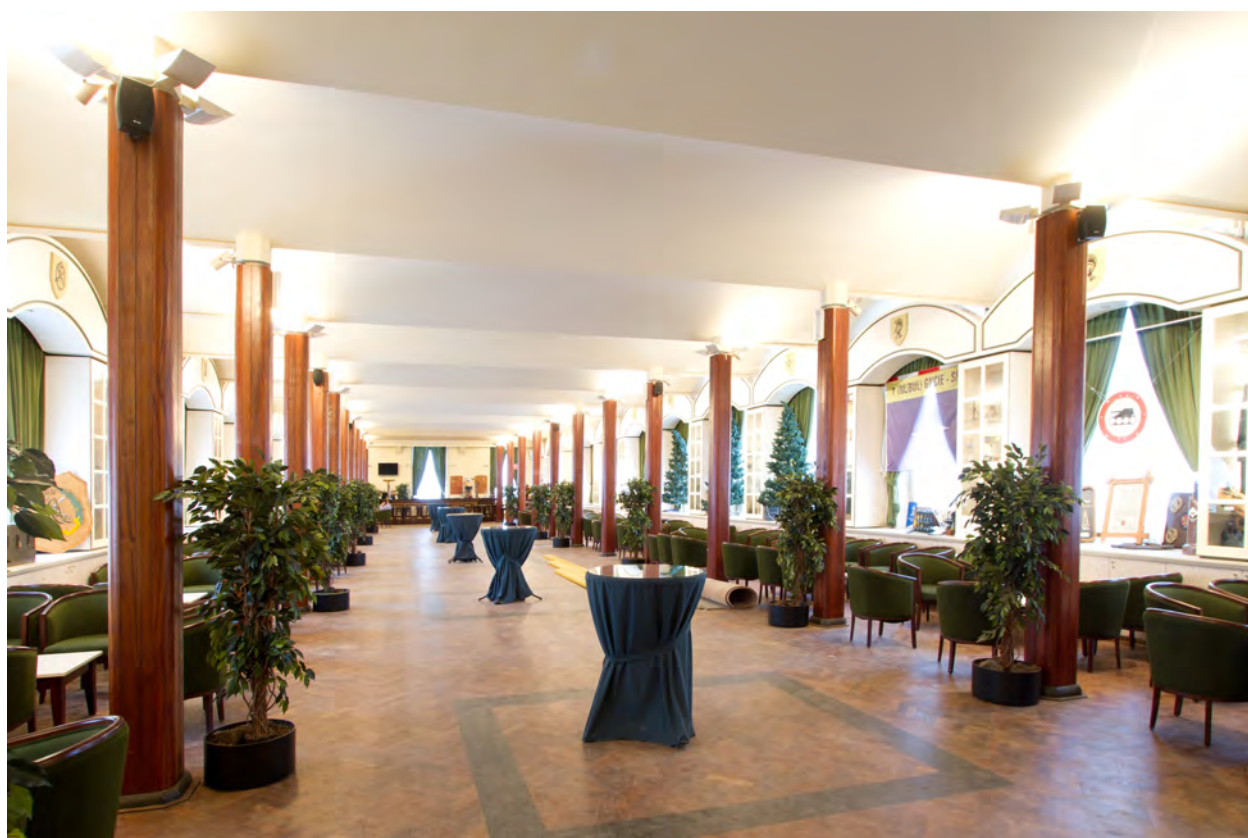
Afb. 57 Overzichtsfoto van de zaal op de eerste verdieping van de westvleugel. Het plafond dateert uit 1948-1950, evenals de (stalen) kolommen die de bovenliggende vloerconstructie ondersteunen.
