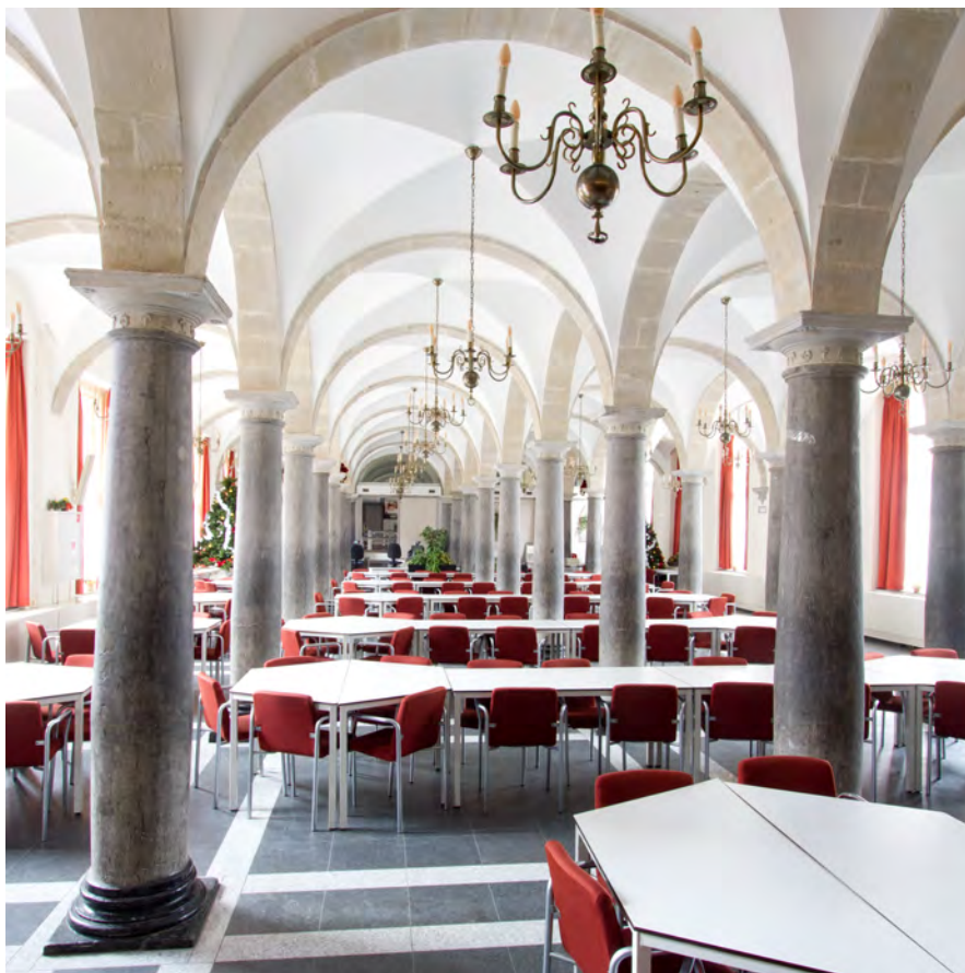
Afb. 47 Opname uit 2011 die de situatie op de begane grond toont: kolommen, gordelbogen en kruisgraatgewelven. In de zestiende eeuw was hier een open galerij beoogd, een verbindend element tussen twee binnenplaatsen met daarboven de zogenaamde Ridderzaal.
