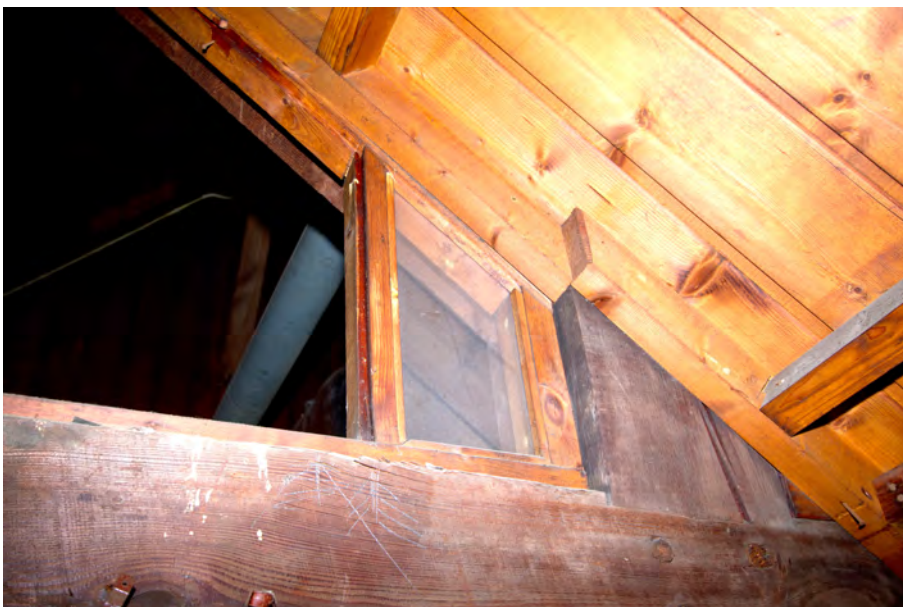
Afb. 21 Detail van een restant van een wand aansluitend op het schuine dakschot. In de wanden is ook glas verwerkt geweest. De balk op de foto is de dekbalk van het spant .
