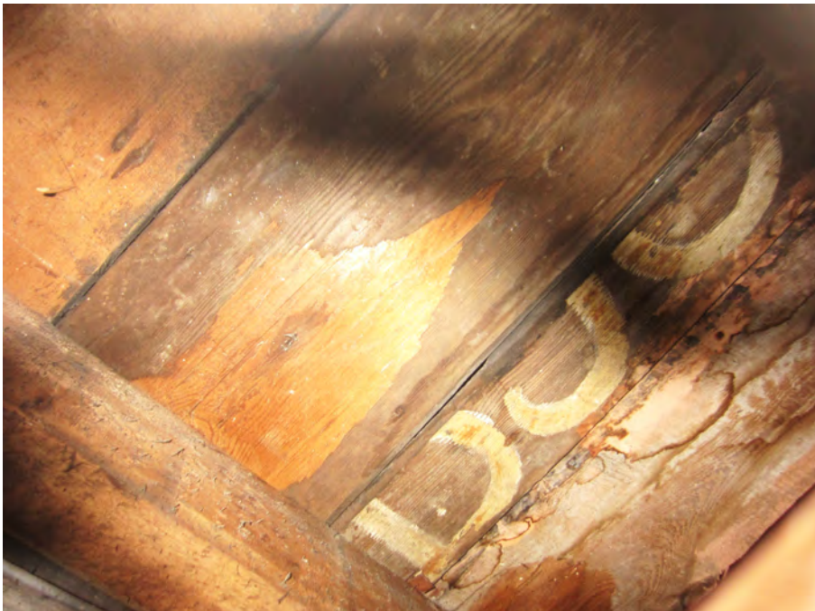
Afb. 63 Foto van enkele vloerdelen, van onderaf gezien. Op één van de delen is een afdruk te zien, van wat letters lijken te zijn. Links daarvan een fragment van een bruinokerkleurige verflaag. Dit duidt op hergebruik van het hout.
