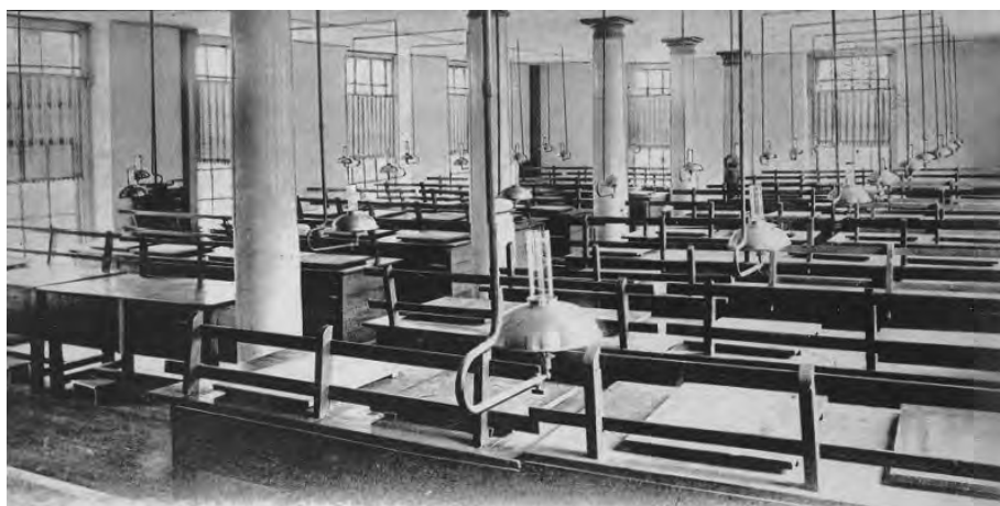
Afb. 129 De tekenzaal in één van de zijvleugels. De zaal heeft nog de oorspronkelijke kolommen uit 1828. De opname zal vermoedelijk uit de late negentiende eeuw dateren. Aan het vlakke plafond hangen de gaslampen.
