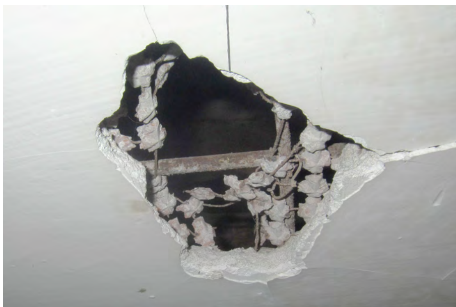
Afb. 67 Een fragment van het stucplafond op de tweede verdieping van de westvleugel, gezien boven de verlaagde plafonds (locatie 11, ruimtenummer 211). Een gat in het plafond toont aan dat hier sprake is van een steengaasplafond op draadraster met een gaas met vierkante mazen. Het plafond kent nauwelijks stuclagen als afwerking en zal derhalve niet langer dan enkele decennia in het zicht zijn geweest.
