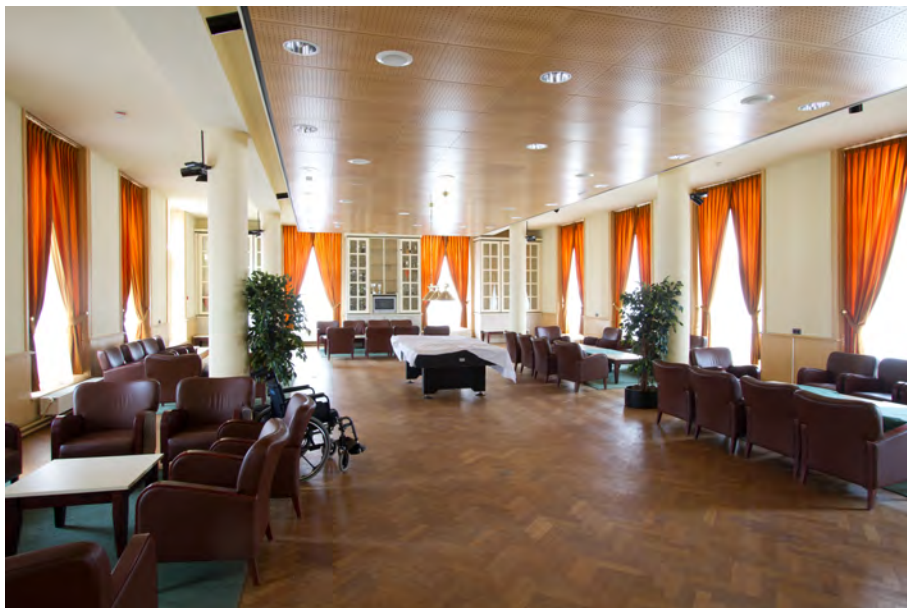
Afb. 156 Opname uit 2011 toont de eerste verdieping van de noordelijke zijvleugel, waar de draagconstructie en de parketvloer uit 1950 dateren.
