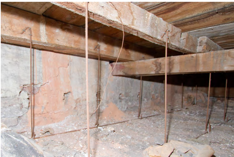
Afb. 65 De westvleugel nabij de noordelijke kopgevel, gezien in richting van de scheidingsmuur met de noordvleugel, onder de zoldervloer. In het muurwerk zijn gaten te zien waarin voorheen balken staken waaraan een ouder stucplafond was bevestigd. Op deze foto zijn de ijzeren staven te zien waaraan het huidige steengaasplafond is gehangen.
