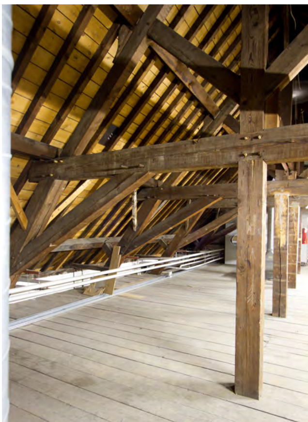
Afb. 166 Deel van de kapconstructie van de noordelijke zijvleugel. De constructie verkeert vrijwel in authentieke staat.
