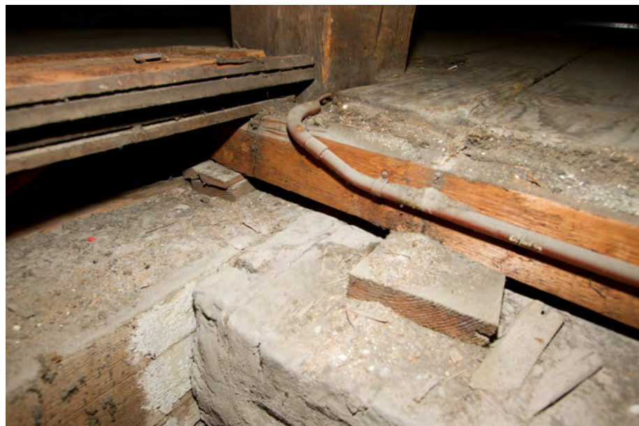
Afb. 113 Opname op de zolder van de zuidvleugel waar te zien is dat de moerbalk is ingewerkt in de gangmuur en dat de bint op hergebruikte vloerplanken op de gangmuur rust. De standvink van het spant staat niet op de muur opgesteld, maar direct daarnaast.
