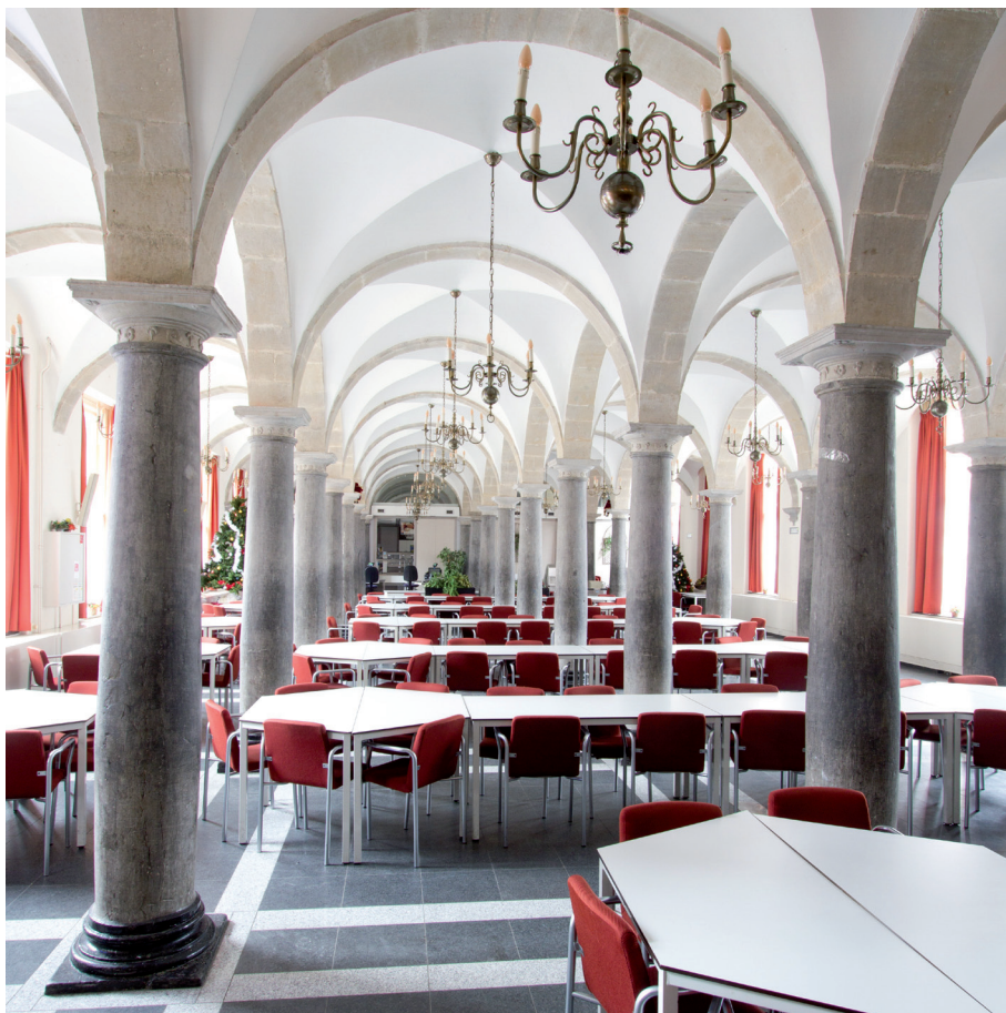
Afb. 12 De kolommen en gewelven van de voormalige open colonnade van de zaal-vleugel, nu eetzaal.
