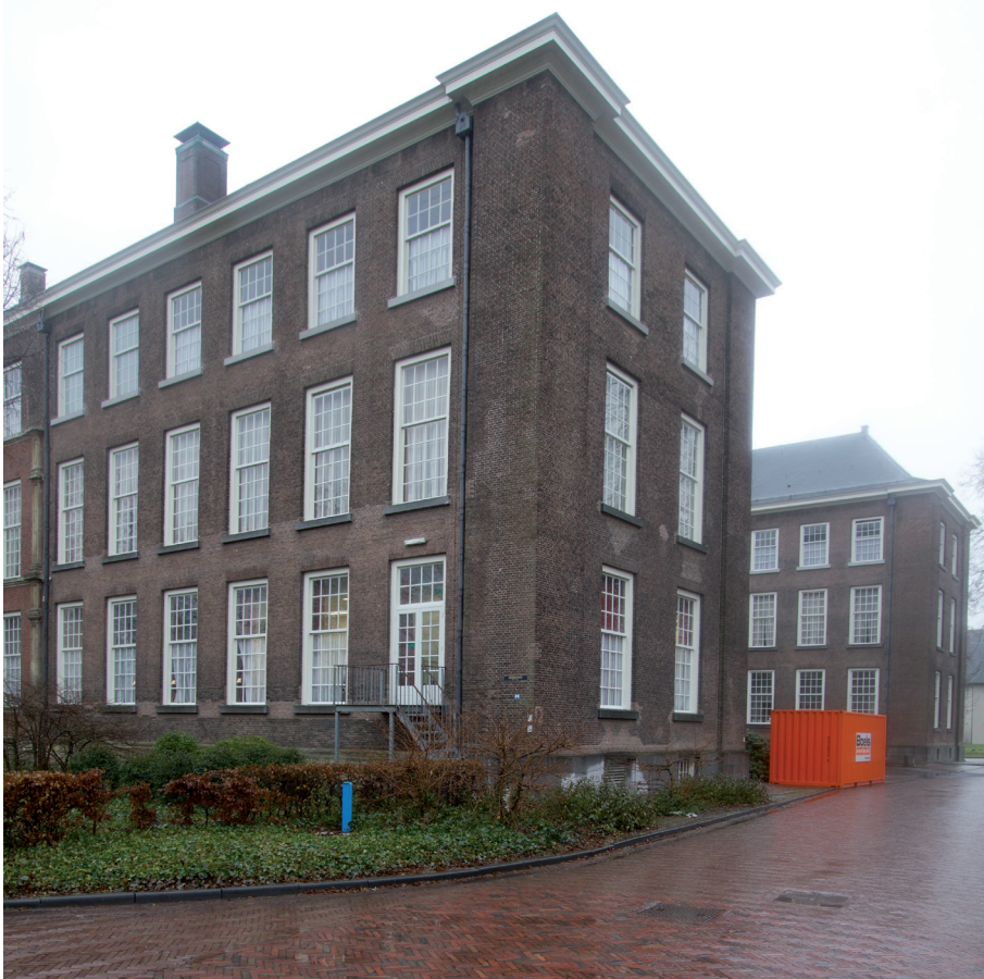
Afb. 29 De noordelijke van de twee in 1826-1828 opgetrokken vleugels.
