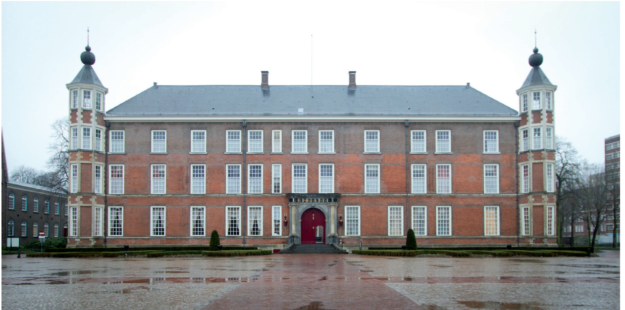
Afb. 1 Het gebouw op de dag van de veldverkenning.
