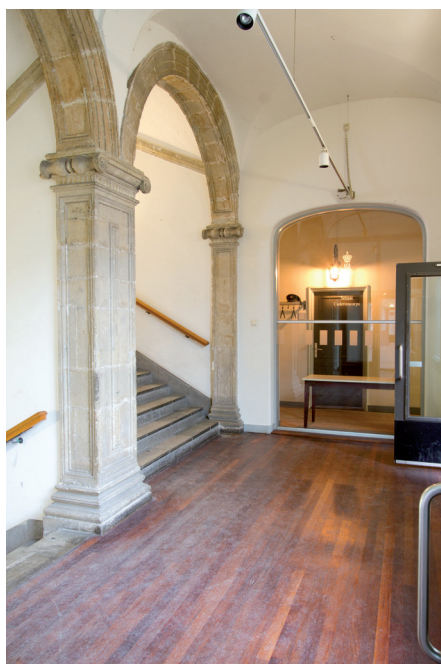
Afb. 48 Natuurstenen pilasters, kapitelen en bogen ter plaatse van het zestiende-eeuwse trappenhuis, gezien op het niveau van de piano nobile.
