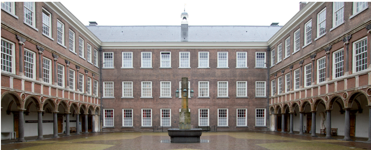
Afb. 25 De zaalvleugel met haar negentiende-eeuwse gevel. Oorspronkelijk werd de gevel gedomineerd door de centrale staatsietrap en de open zuilengalerij op de begane grond.
