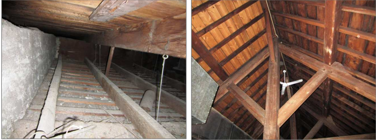
Figuur 4 Afbeelding van de onderzijde van de plankenvloer van de zolder, waarop tevens het oude stucwerkplafond van de tweede verdieping te zien is (links); Op de zolderverdieping is de houten dakconstructie zichtbaar
