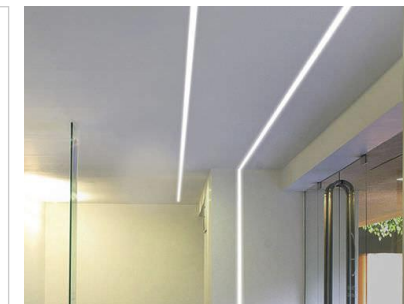
S4. inbouw led lichtlijn in plafond
