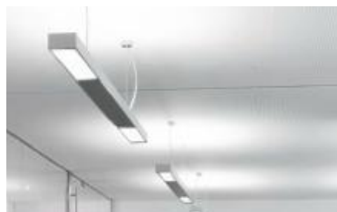
pendelarmatuur (als opbouwarmatuur gebruiken)
