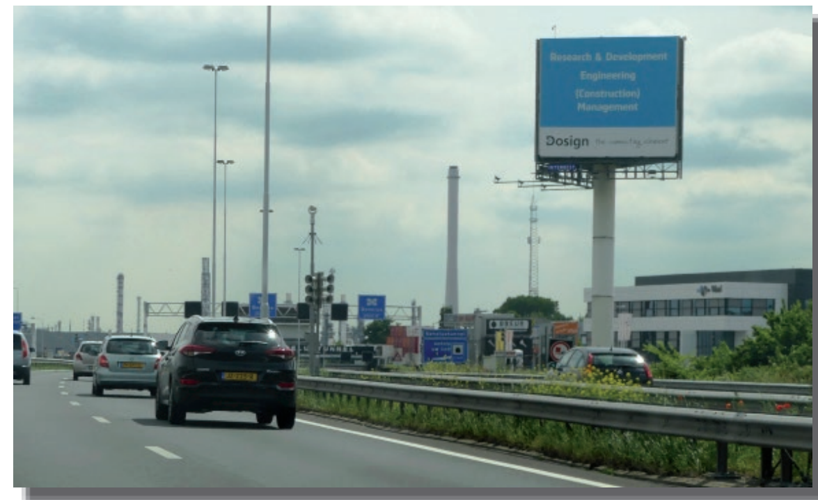
FOTO 3 : BESTAANDE ADVERTENTIE- ZUIL
