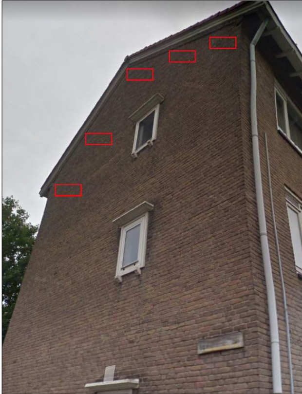
Figuur 3. Globale positie van de nieuwe inbouwnestkasten voor gierzwaluwen in kopse gevel van portiekflat. In totaal worden vier kopgevels voorzien van elk vijf nestkasten. Vijf nestkasten in de kopgevel aan de Moerbeistraat waar nu het nest aanwezig is en de andere 15 nestkasten op de kopgevels met een noord oriëntatie
