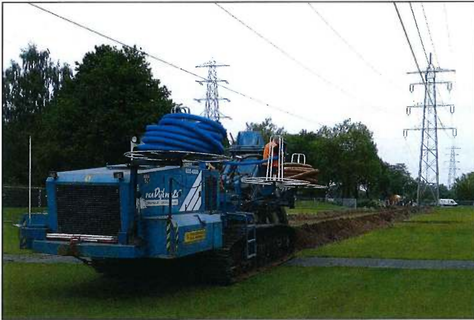
Figuur 5: Aanleg drainage met drainmachine
