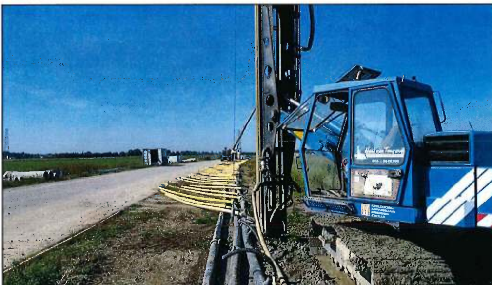
Figuur 6: Aanbrengen zwaartekrachtbemaling middels spuitboren
