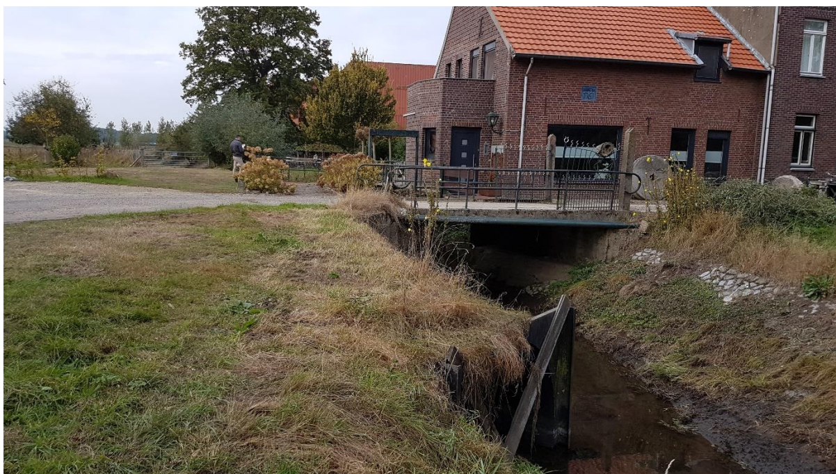
Figuur 5: Huidige situatie ter plaatse van de Volmolen.
