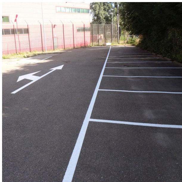
MARKERINGEN EN AANDUIDINGEN GEVERFD
