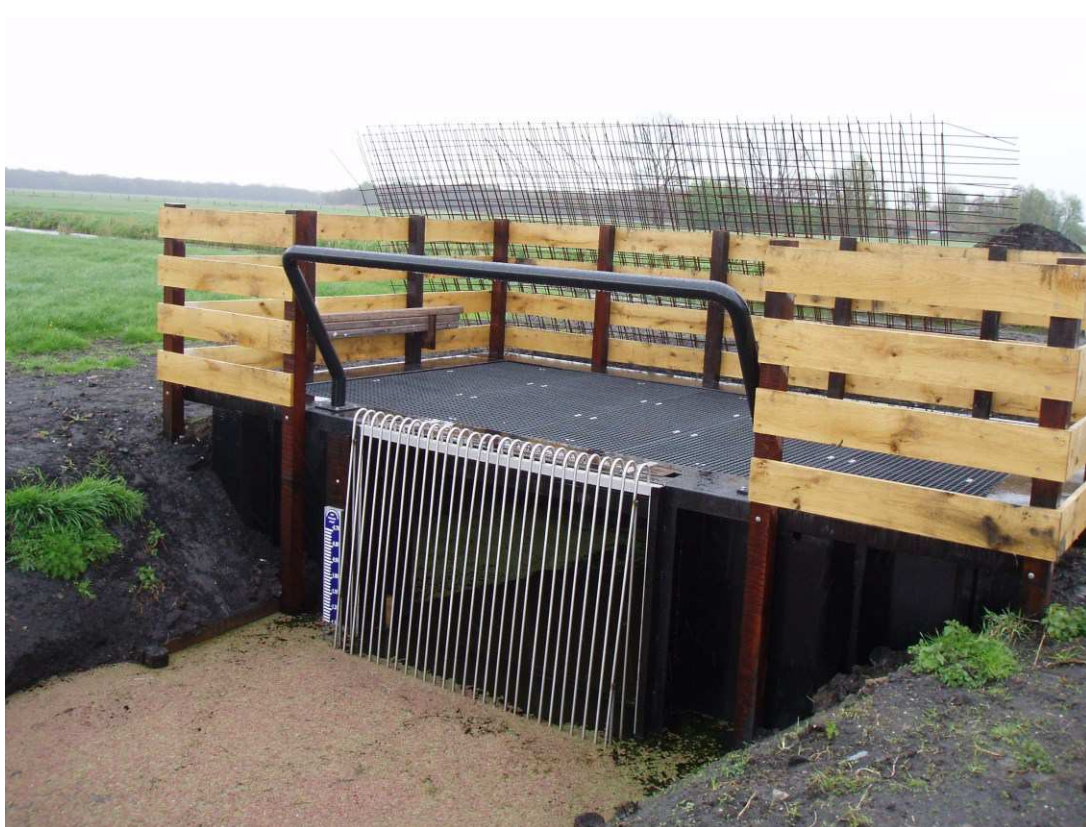
Voorbeeld hekwerk rondom de instroom opening.
