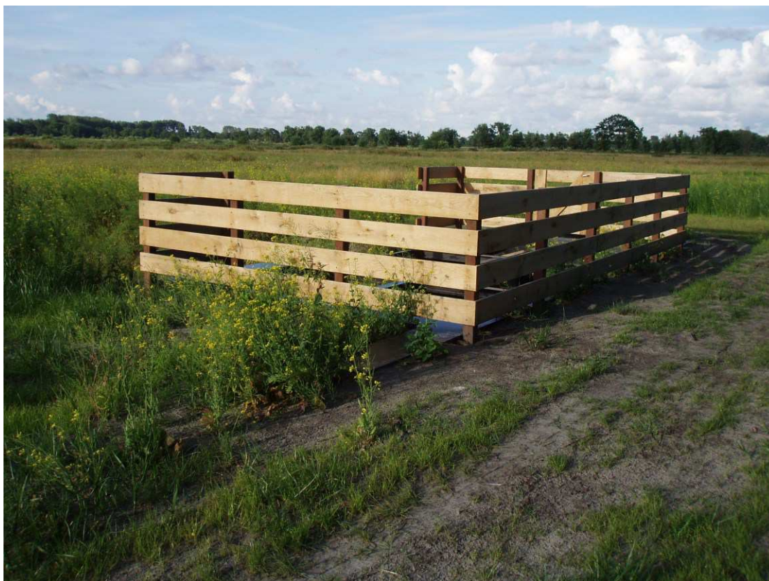
Voorbeeld van uitstroom opening met veekering
