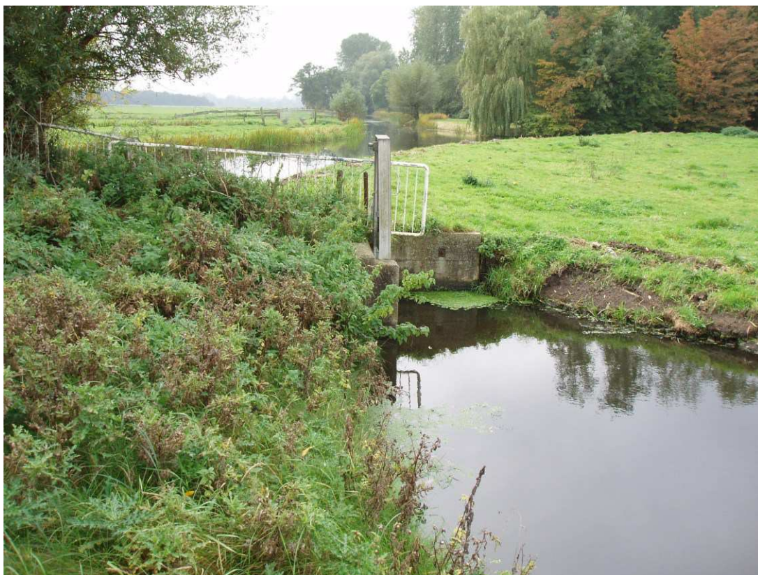
Ter hoogte van instroomzijde damwand plaatsen
