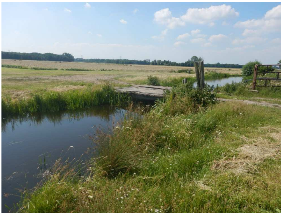
Overzicht bestaande landbouwbrug in het boezemwater.
