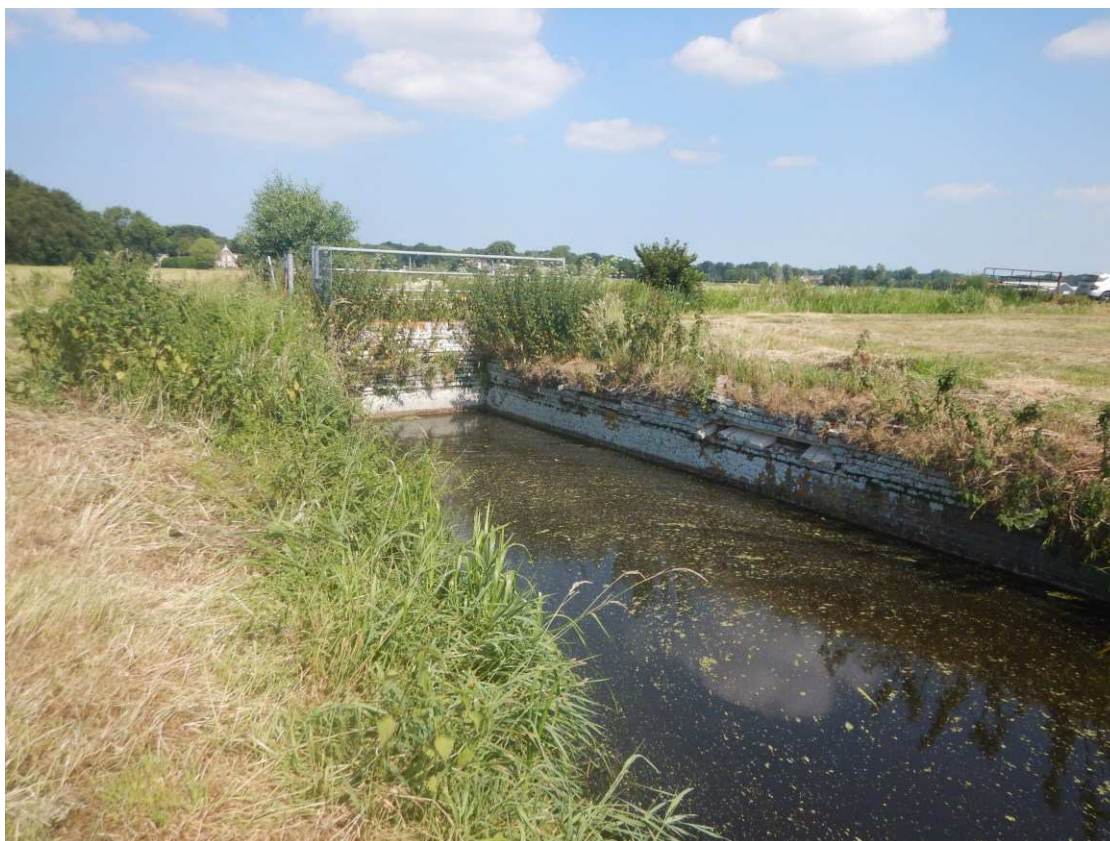
Ter hoogte van uitstroomzijde damwand plaatsen.
