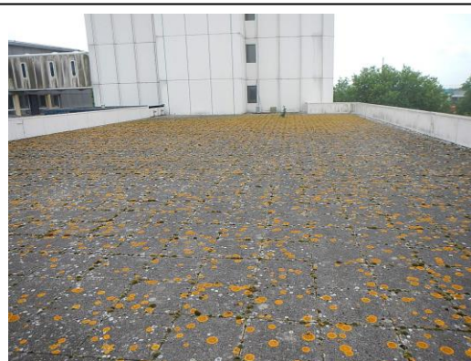
Overzicht van het dak
