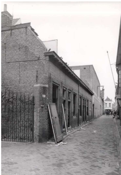
Afbeelding 17: De bebouwing langs de noordzijde van de Bleekstraat circa 1965 kort voor de afbraak ten behoeve van de huidige bebouwing, gezien vanuit het westen, met op de voorgrond de vijf in 1926 opgehoogde woninkjes (Bron: Vocus 2017).
