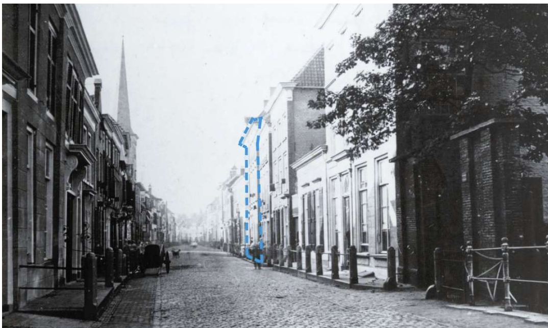
Afbeelding 13. De Ginnekenstraat ca. 1860 gezien vanuit de brug over de Oude Vest (nu kruising met de Karnemelkstraat). De met blauw aangeduide gevel stond ter hoogte van het plangebied (bron: Vocus 2017).
