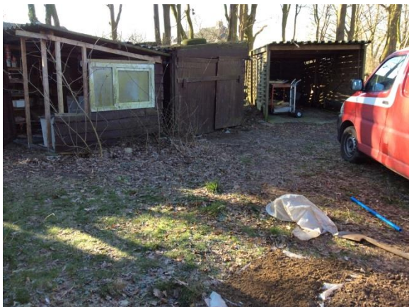
Figuur 8: Overzichtsfoto bebouwing
