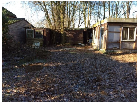
Figuur 9: Overzichtsfoto bebouwing
