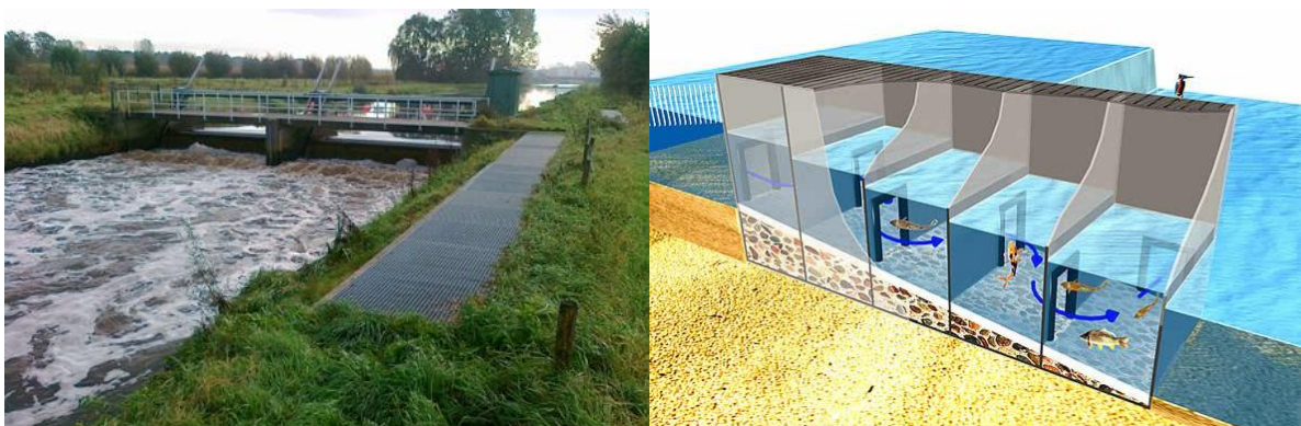
Figuur 10. Links, toepassing 'De Wit' passage in de Aa. Rechts, schematisatie van een dergelijke vispassage.
