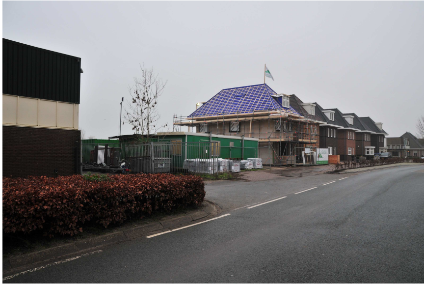
Figuur 3.1.1 Foto huidige situatie
