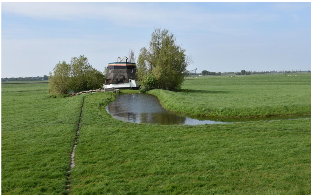
Figuur 4.16. Hoogwatervoorziening WW-15HW01, tevens inlaat.
