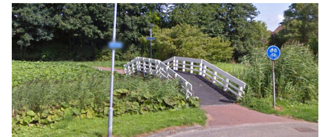
Reeds gerealiseerde bruggen, type C1 en C2
